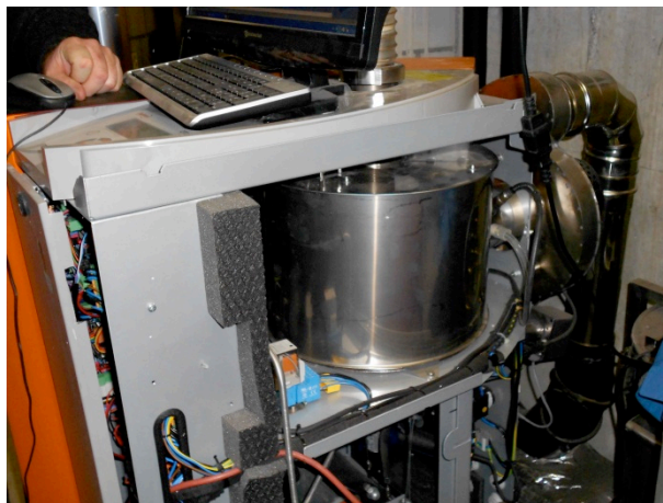
Abbildung 8 Pelletbrenner der Mikro-WKK-Dampfanlage
