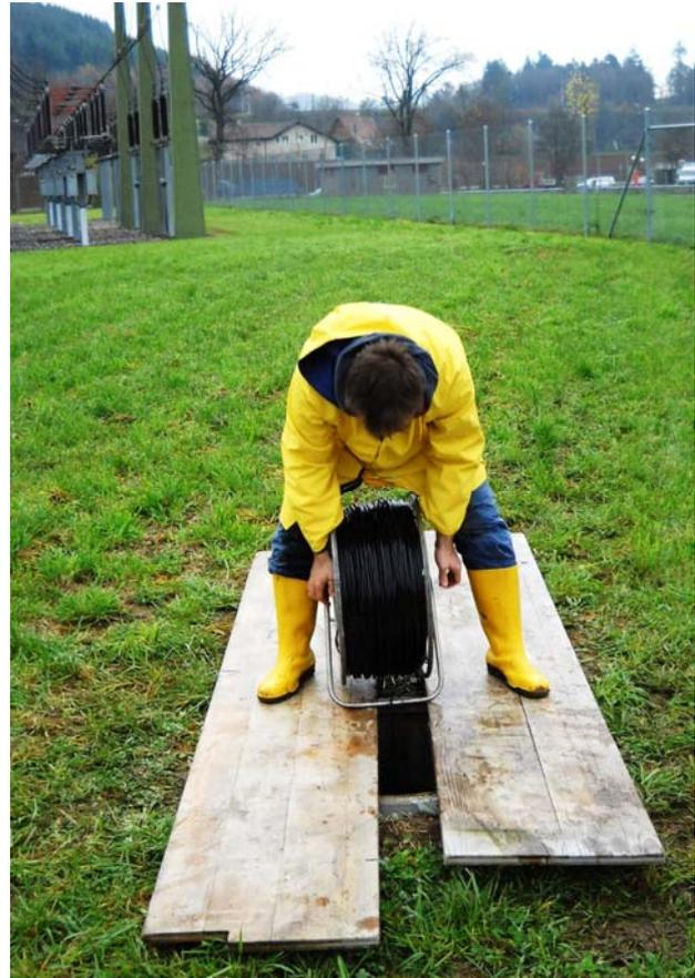
**Fig. 5:** Installation des tiefsten Temperaturfühlers in 700 m. Bei der Inbetriebnahme des tiefsten Sensors wurde ein Wert von 48.6 °C gemessen.
