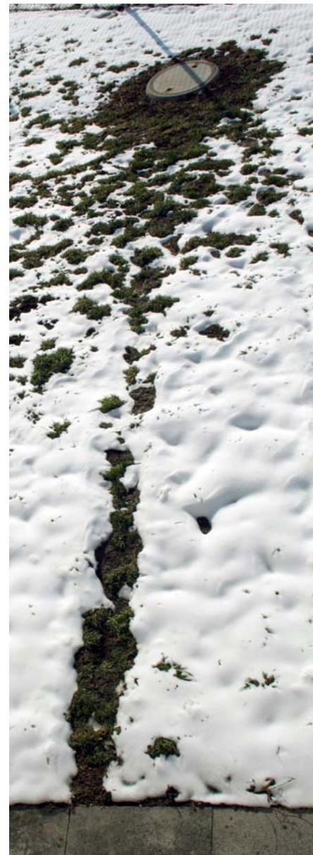
**Fig. 30:** Wärmeverlust durch nicht isoliertes und oberflächennah verlegtes Rohrstück zwischen Sondenaustritt (Kanalschacht) und Gebäude.
