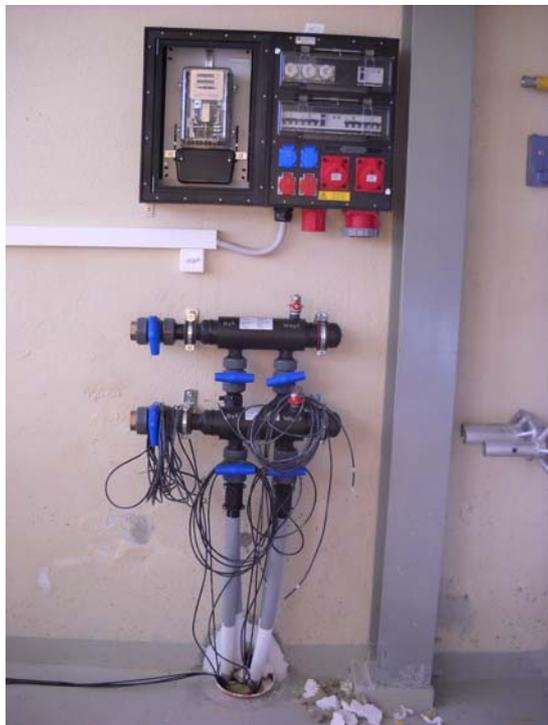
Durchführung der Messkabel durch den Sondenkanal. Auf dem Foto ist die verwendete EWS (GESER-S.I.C.U.R.) gut zu sehen.
