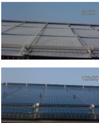
Figure 4 : Les absorbeurs solaires utilisés par la pompe à chaleur comme échangeur givrent en l'absence de soleil matinal (ESSA).
