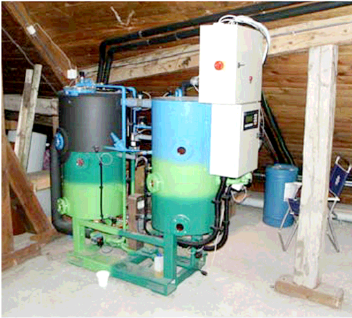
Figur 14 : Absorptionsmaschine Weingut Schloss Salenegg (EAW WEGARCAL 15)
