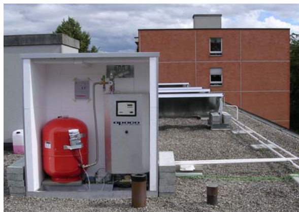
Figure 12: Solarinnovation: Über das in einem wettergeschützten Gehäuse untergebrachte Solar-Kompaktmodul heizen Solarkollektoren direkt das zirkulierende Warmwasser von Mehrfamilienhäusern. Dazu wird die Zirkulationsleitung vom obersten Geschoss bis aufs Dach verlängert. [Foto: Oekozentrum Langenbruck]
