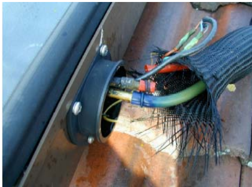
Figure 13: Verfärbte Silikonschläuche nach wenigen Betriebsjahren
