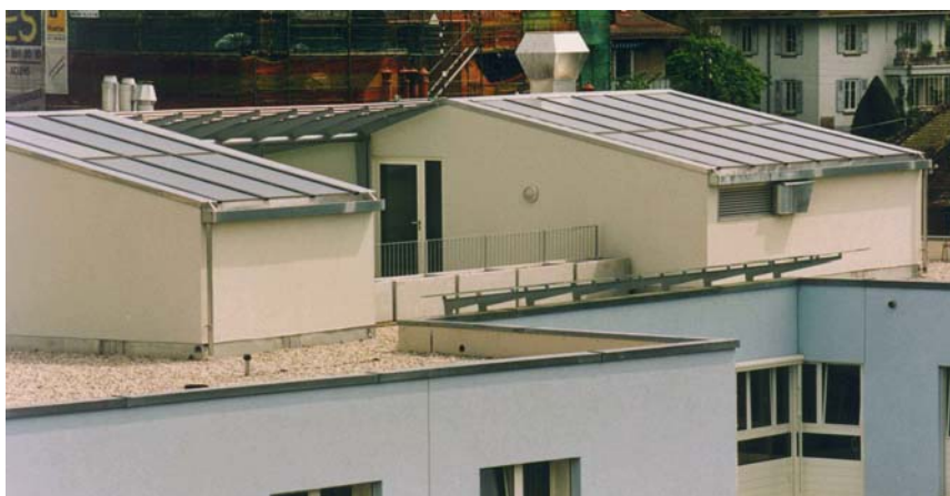
Figure 9: Capteurs solaires sur l'EMS Primeroche à Prilly : une intégration très réussie
