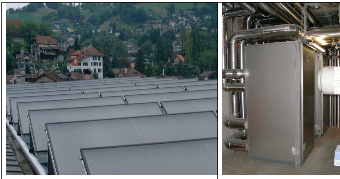
Figure 11 : Banque Cantonale Bernoise à Thoune : 100 m 2 de capteurs en toiture (à gauche) et 2 machines frigorifiques à absorption (couple H 2 O–LiBr) de 46 kW froid chacune (à droite)
