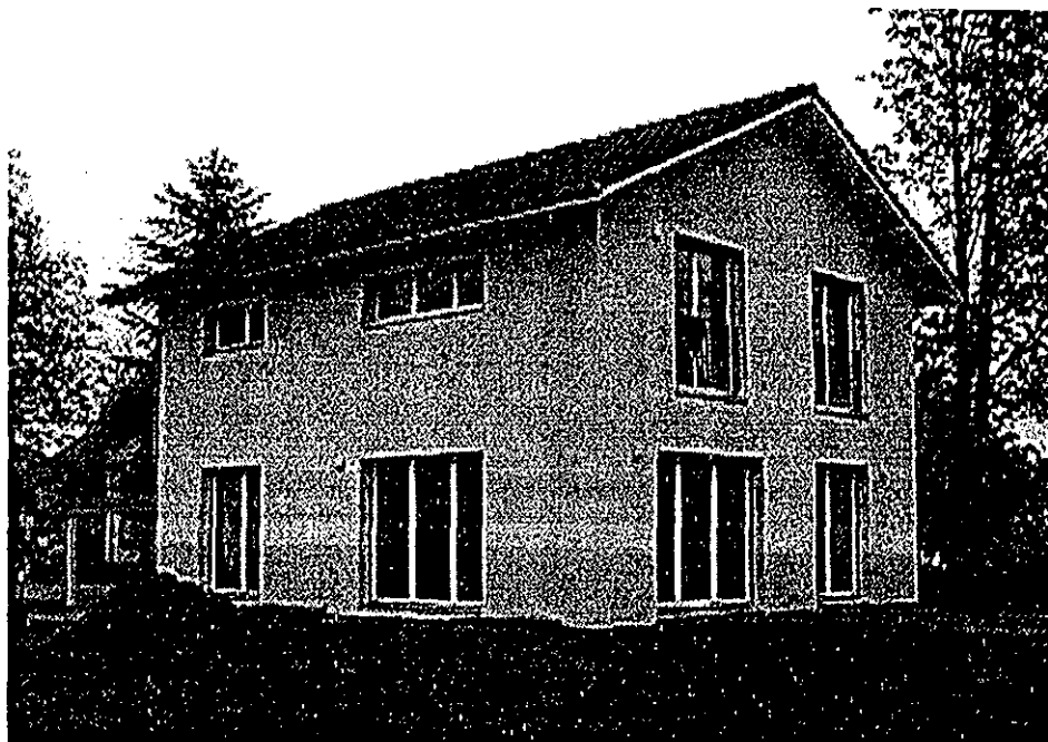
Abb. 8: Süd-West-Ansicht der Pilotanlage 2
