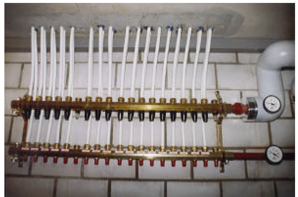
Abb. 3-14: Heizungsverteiler einer selbstregulierenden Fussbodenheizung ohne Thermostatventile. Die maximale Heizkreislänge von 100 m ergibt meist 2 Kreise pro Raum.
