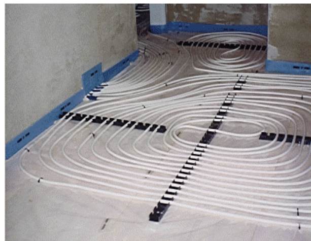
Abb. 2-29: Fussbodenheizungsrohre in einem EFH in Bubendorf BL mit einer 30/25 °C Fussbodenheizung. Der Verlegeabstand beträgt 5 cm [Foto: Bircher + Keller AG].
