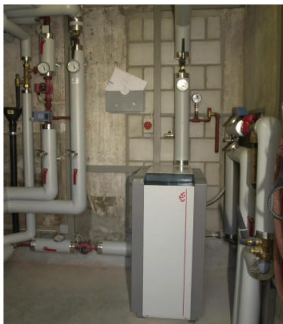
Abb. 2-32: Wärmepumpe der Firma CTA AG, Münsingen.
