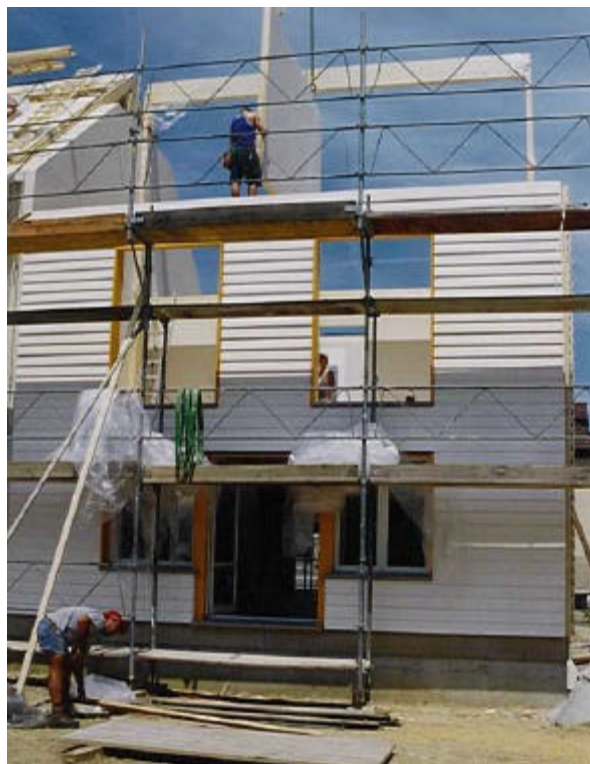
Abb. 4-1: Montage des vorfabrizierten Serienhauses in Grafstal.
