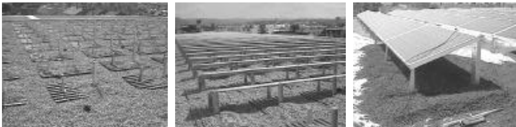
Bild 7. Bilder vom Einbringen und Montieren der Solarmodulaufständern bei einer grossen Flachdachanlage in der Schweiz.
