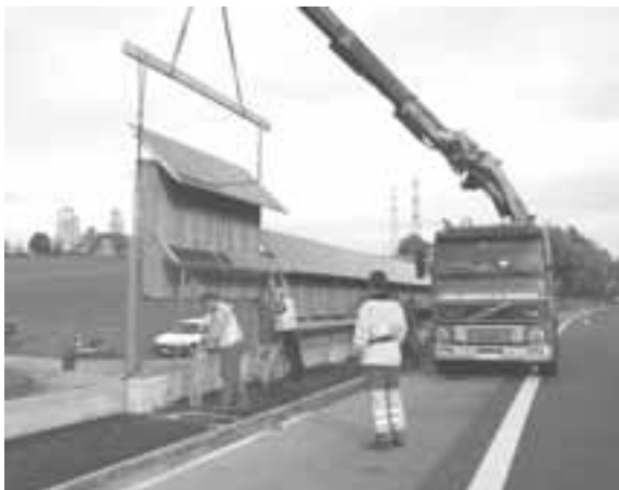
Bild 05 Beginn der PV-Schallschutzanlage-Montagearbeiten vor Ort auf der A1 in Safenwil. Stand der Arbeit am 30. Okt. 2000.
