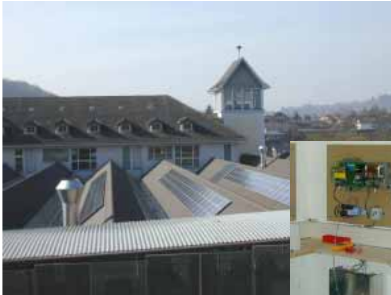
Bild 3 oben: Ausschnitt der 250 kWp Anlage mit LON Wechselrichtern, rechts: Prototypen im Labor Fotos: NET AG
