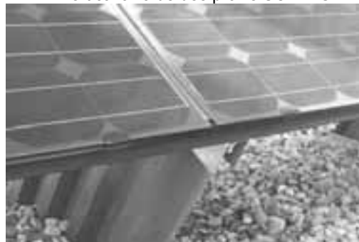
Bild 8: Les modules lamifiés sont fixés sur le support vertical à l'aide des profils SOLFACE
