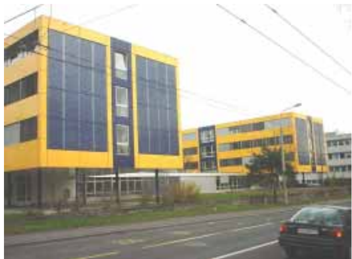
Photo 6: Les façades PV de l'installation 'Rhodanie'
