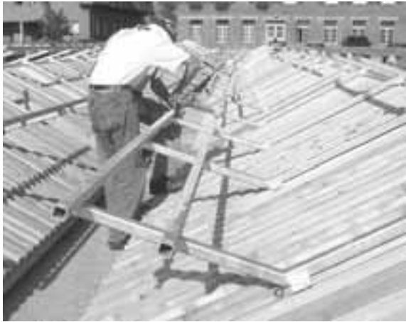
Bild 03 Vormontage der Tragkonstruktion für die Aufnahme der Photovoltaikmodule. Stand der Arbeiten am 12. Sept. 2000.
