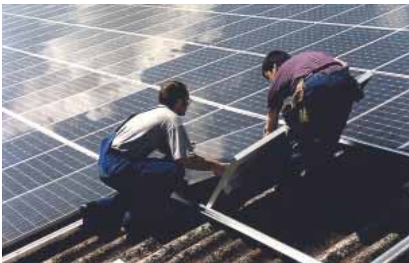
Bild 7: 32 kWp Anlage Hünenberg, Modulmontage mit der AluTec / AluVer Unterkonstruktion
