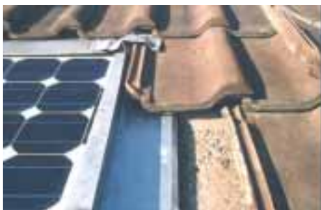
Bild 6: Beispiel ABZ mit Stahlblech
