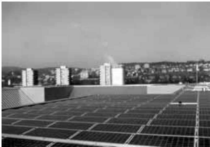
Abb. 1: Photovoltaikanlage auf dem Dach der IBM in Altstetten. Die Neigung der Module beträgt lediglich 5° und die Anlage liegt zwischen Autobahn und Eisenbahnlinie.
