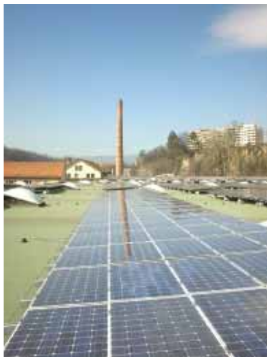
Photo 1: Détail de l'installations TPG
