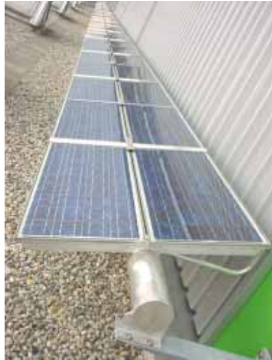
Photo 4: Vue détails panneau
