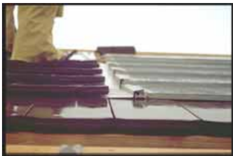
Bild 4, 5: Beispiel DEMOSITE mit Uschinox
