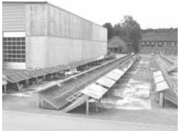
Bild 04 Ansicht des Vormontage-Werkareals in Frick, wo auch die Wandelemente gefertigt wurden. Stand der Arbeiten am 2. Okt. 2000.
