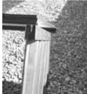
Bild 8: Les modules lamifiés sont fixés sur le support vertical à l'aide des profils SOLFACE
