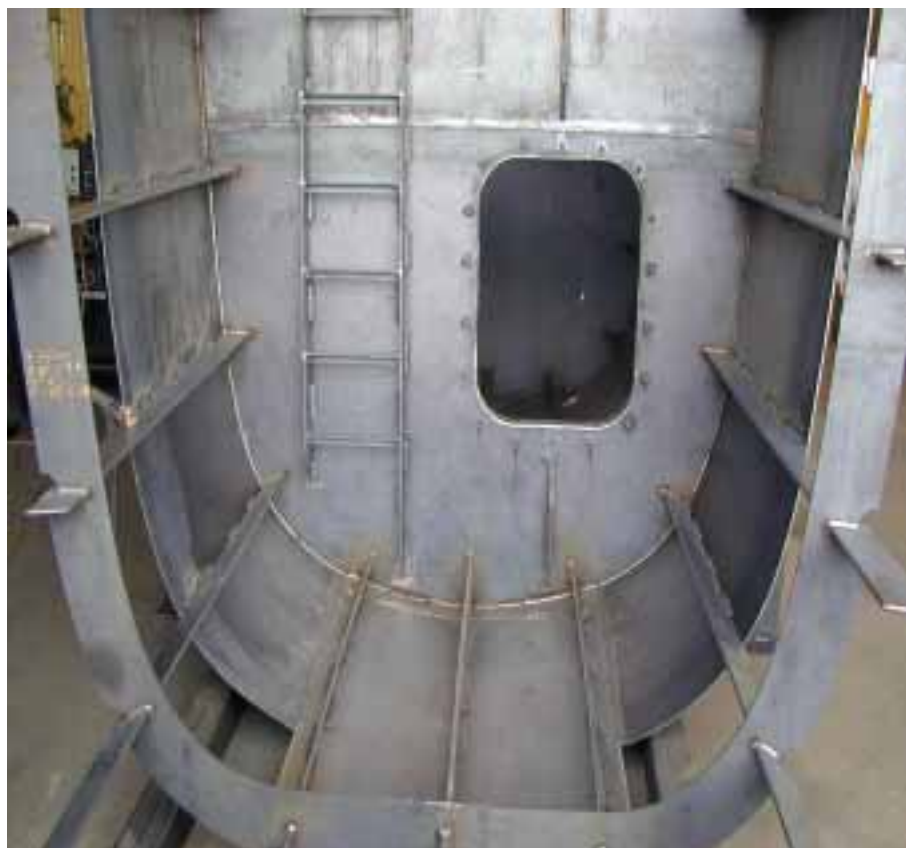
Bild 3: Innenansicht eines Rumpfelements
