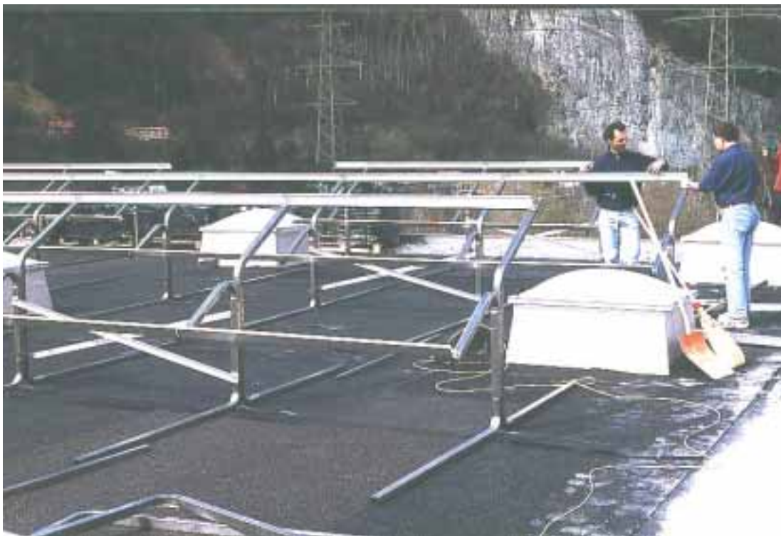
Bild 1: Aufbau der Edelstahl Tragkonstruktion
