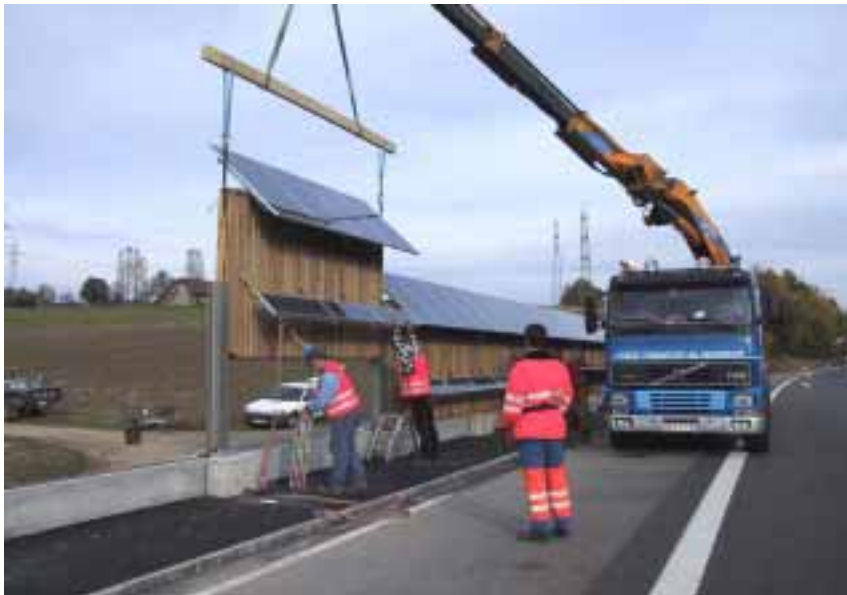
Bild 5: Montage der 80 kWp PV Schall- schutzanlage Safenwil Foto: IG Solar Safenwil
