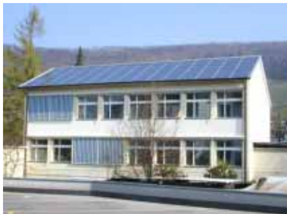
Bild 5: Dachintegration mit SOLRIF Wettingen (Bildquelle: NET AG)
