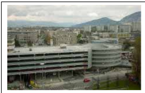
Vue de l'ouest avant le montage du toit photovoltaïque
