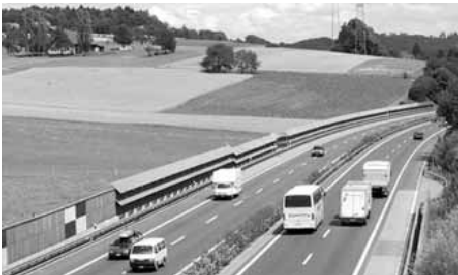
Fig. 1: Ansicht der fertig erstellten Anlage an der Autobahn A1 in Safenwil, Fahrspur Zürich - Bern.
