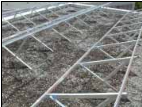
Abb. 5 Die Unterkonstruktion wird auf den Deltatec-Platten verankert.
