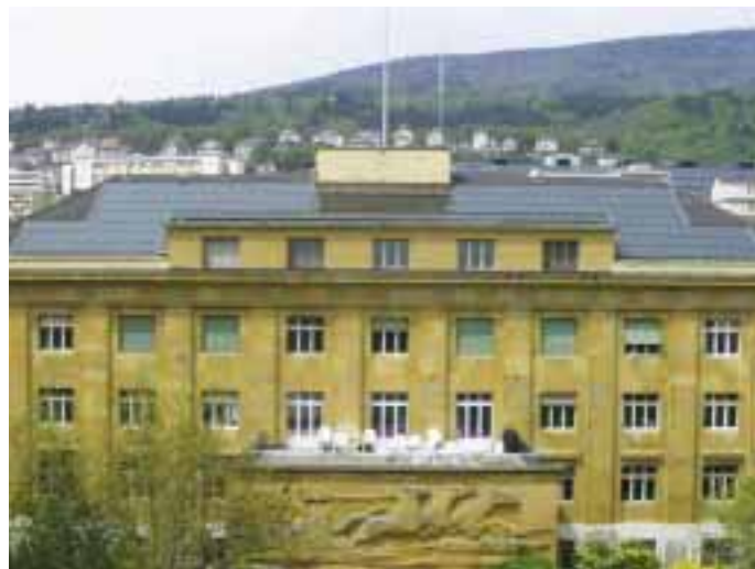
Figure 1 : Installation photovoltaïque intégrée IMT Neuchâtel
