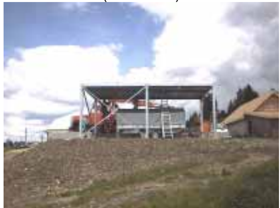
Montage - Vue d'ensemble, face ouest (13.06.2001)
