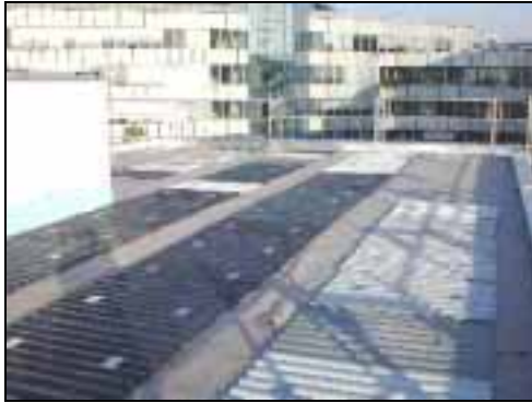
Abb. 3 Deltatec-Platten werden auf dem Dach verlegt und dienen als Anker der Konstruktion
