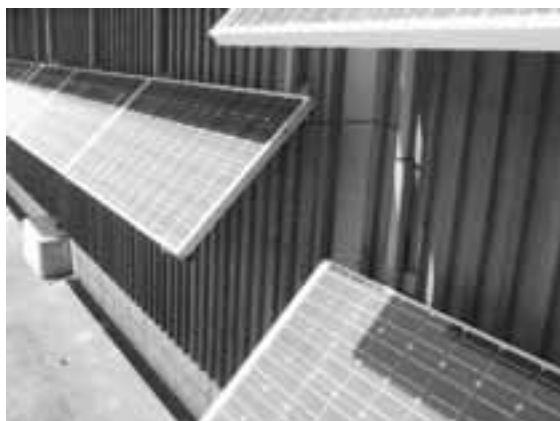
Fig. 7: Dieses Bild zeigt deutlich die Teil-Beschattung auf der unteren Modulreihe. Aufnahme vom 21. Juni 2001 um 13.00 Uhr (Einstrahlwinkel gem. Sonnen-Höchststand)
