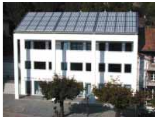
Bild 18: PV Dächer Altstadt Unterseen (Bildquelle: NET AG)
