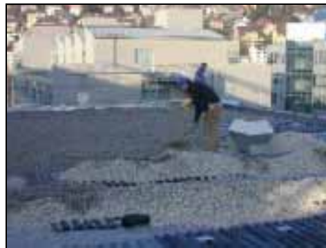
Abb. 8: Kies wird auf die Platten aufgetragen
