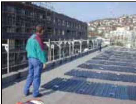
Abb. 7: verlegte Deltatec Platten
