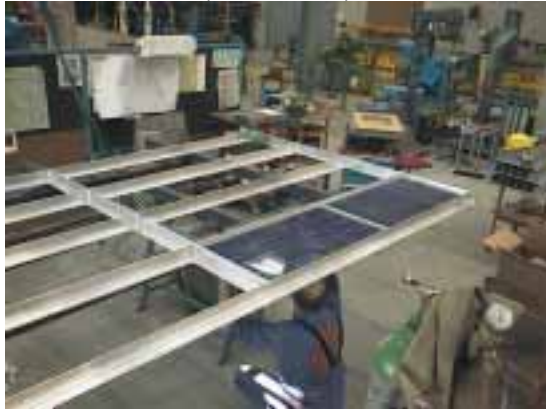
Atelier - Vue d'ensemble (01.02.2001)
