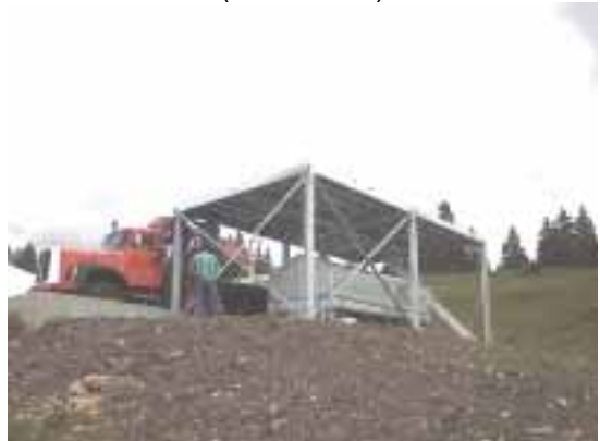
Montage - Vue d'ensemble, angle nord-ouest (13.06.2001)
