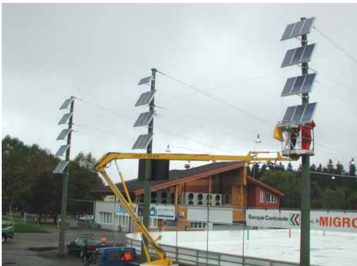
Figure 7: Montage de la 3 ème unité de production (octobre 2001)
