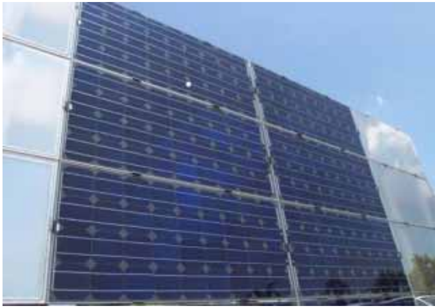
Fig. 2 Vue du pavillon Demosite
