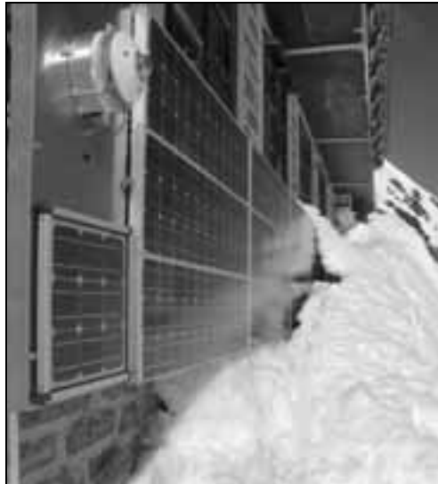
Bild 4: Der Ost-Generator am 07.05.01. Im Monat April, Mai und Juni 2001 wurde der Generator zeitweise massiv durch Schneeansammlungen verschattet. Die Solarmodule der Anlage Jungfraujoch sind immer in horizontaler Richtung zu Strängen von je 4 Module verschaltet. Bei Verschattung der hinteren Module, wie hier auf dem Foto zu sehen, liefern die einzelnen Stränge kaum noch Energie.
