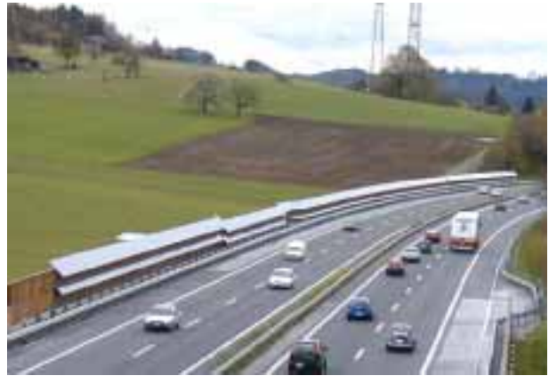
Bild 17: Schallschutzanlage A1 Safenwil (Bildquelle: BFE)
