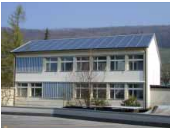
Bild 10: Dachintegration mit SOLRIF Wettingen (Bildquelle: H.-D. Koeppel)
