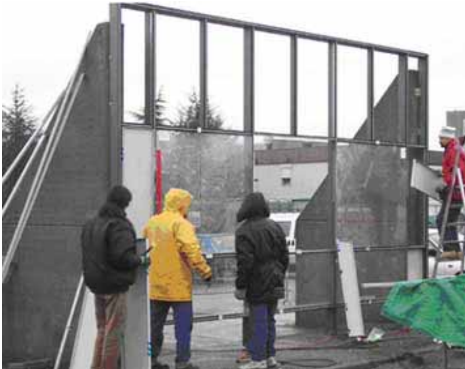
Fig. 8 : montage du stand Kawneer.
