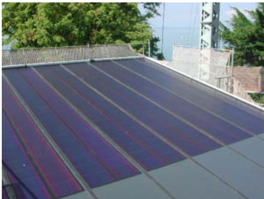
Fig. 7: détail de la grande toiture équipée de lamifiés de 5m50 de longueur.
