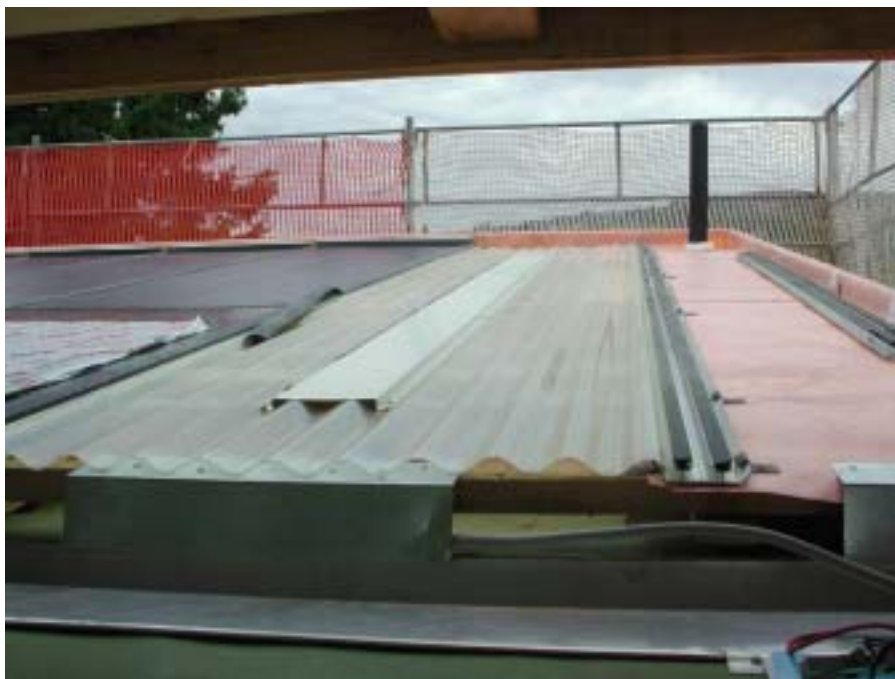
Fig. 1: détail avec le profilé et la sous-couverture étanche en feuille ondulée de polyester armé
