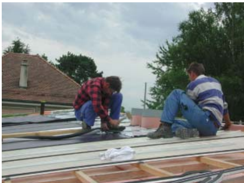
Fig. 2 et 3: insertion du joint EPDM dans le profilé aluminium
