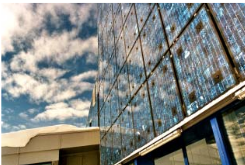
Bild 4: Ausschnitt PV Fassade
