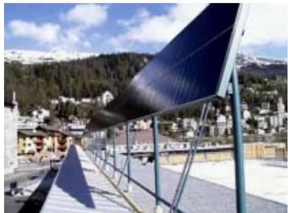
Bild 8: 16,8 kWp Anlage mit CIS Zellen St. Moritz (Bildquelle: LEE-TISO)
