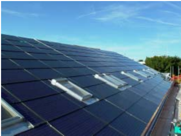
Abb. 4 & Abb. 5 PV-Dach in Herisau, Einbettung von Dachfestern
