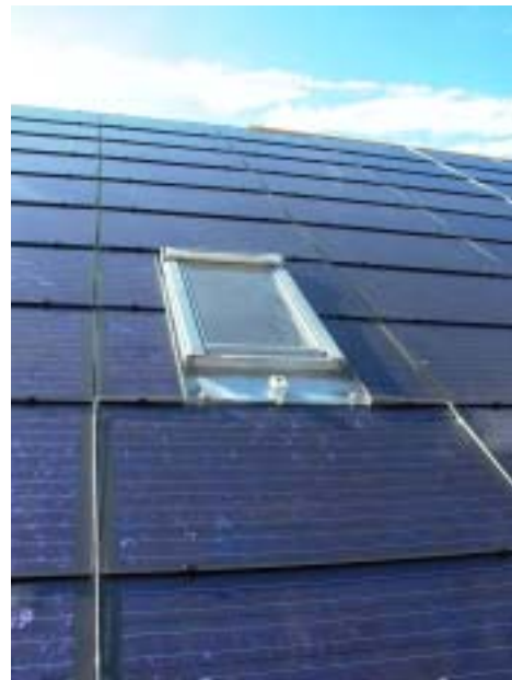
Abb. 4 & Abb. 5 PV-Dach in Herisau, Einbettung von Dachfestern
