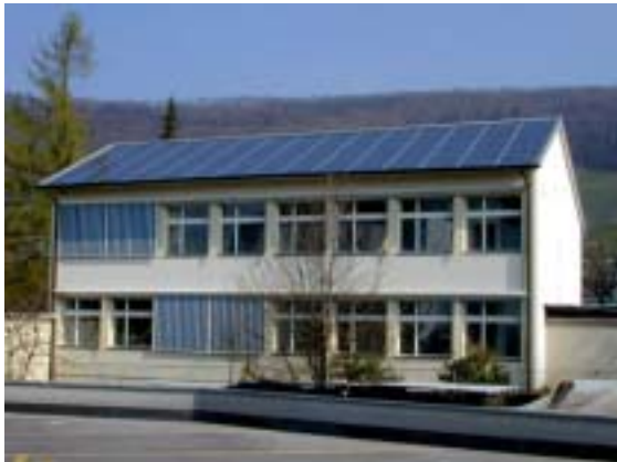
Bild 15: 12,75 kWp Dachintegration Wettingen (Bildquelle: NET AG)
