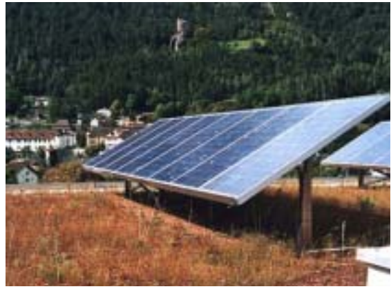
Bild 14: 10 kWp Gründachanlage Solgreen Chur (Bildquelle: NET AG)
