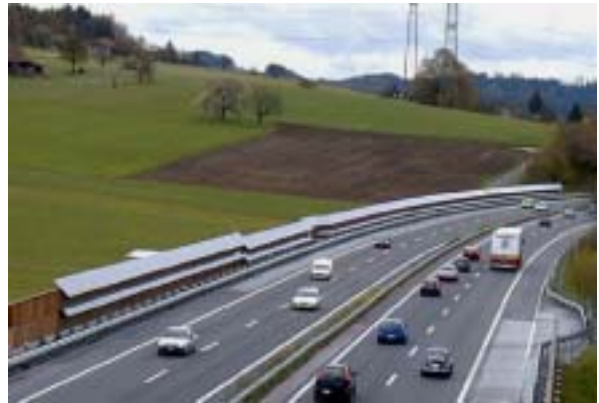
Bild 20: 75 kWp Schallschutz Anlage A1 Safenwil (Bildquelle: BFE)
