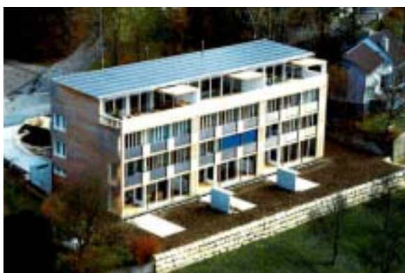
Fig. 9: Sunny Woods roof integrated photovoltaics installation (Photo: Architekturbüro Beat Kämpfen)
