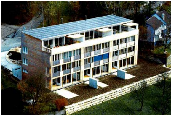
Bild 9: Photovoltaik Dachintegration Sunny Woods (Bildquelle: Architekturbüro Beat Kämpfen)
