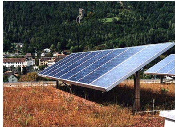
Bild 14: 10 kWp Gründachanlage Solgreen Chur (Bildquelle: NET AG)
