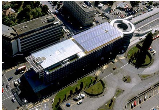
Bild 10: Dachintegration Parking de l'étoile Genf (Bildquelle: Sunwatt Bio Energie SA)
