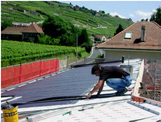
Bild 11: Montage der PV Dachintegration mit amorphen Tripelzellen 'Freestyle®' in Lutry, (Bildquelle: Solstis)
