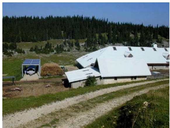
Bild 18: Autonome Anlage Alp Amburnex (Unterstand); (Bildquelle: Service Industriels Lausanne)
