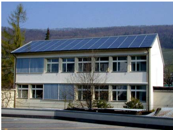
Bild 15: 12,75 kWp Dachintegration Wettingen (Bildquelle: NET AG)
