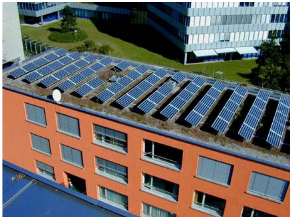
Bild 21: Solgreen Kraftwerk 1 Zürich (Bildquelle: NET AG)
