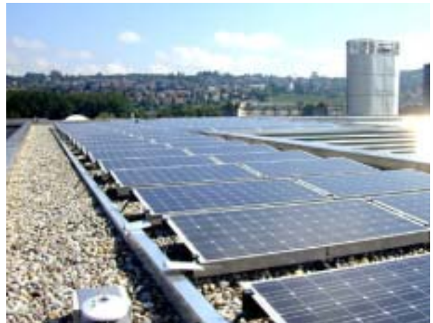
Figur 29: 47 kWp Flachdachanlage IBM Zürich (Bildquelle NET)
