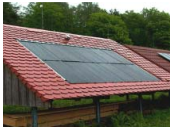
Figur 5: Demonstrationsanlage für den Freilufttest mit CIS-Elementen im Projekt HIPERB (Bildquelle 3S)
