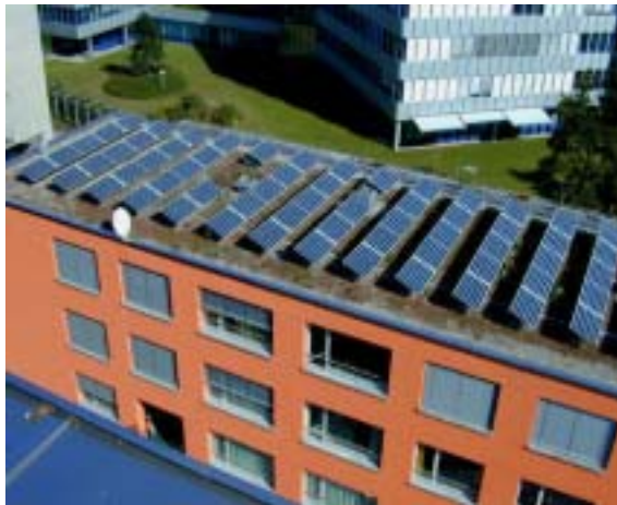
Figur 28: Gründachanlage Solgreen Kraftwerk 1 (Bildquelle NET)
