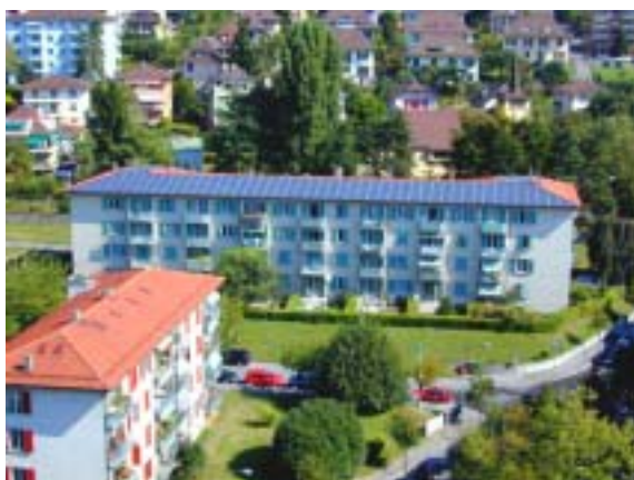
Figur 14: SOLRIF Dachintegration 'Florency' Lausanne (Bildquelle NET)
