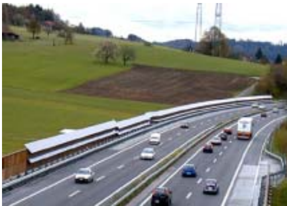
Figur 34: 75 kWp Schallschutzanlage A1 Safenwil (Bildquelle BFE)
