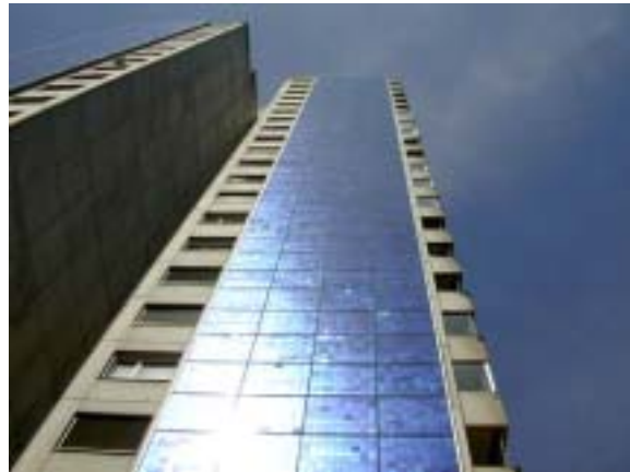
Figur 21: 80 kWp Fassade Bern Wittigkofen (Bildquelle NET)
