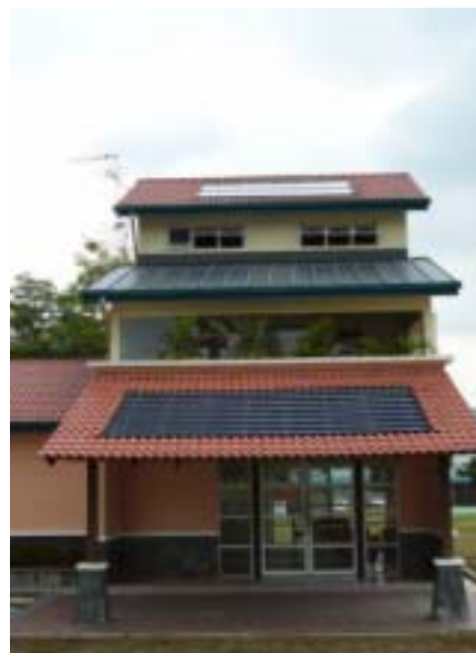
Figur 2: Gebäudeintegrierte Anlage in Malaysia, Bildquelle: Enecolo
