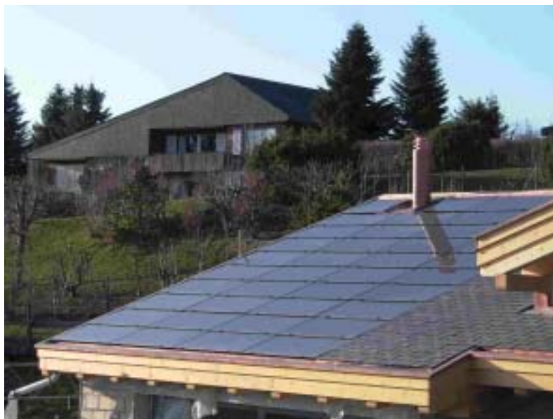
Abb. 1 Dach ohne Schnee
