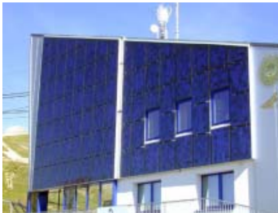
Figur 26: 9.7 kWp Fassade 'Piz Nair Talstation' (Bildquelle NET)
