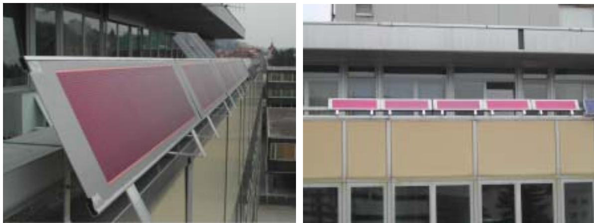
Figur 9: Ansicht der netzgekoppelten Anlage auf dem Dach des EIAJ in Le Locle, bestehend aus 5 Modulen zu je 7W_{peak} .
