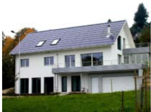
Figur 13: Solarhaus 'Erni' mit SOLRIF Dachintegration (Bildquelle Enecolo)
