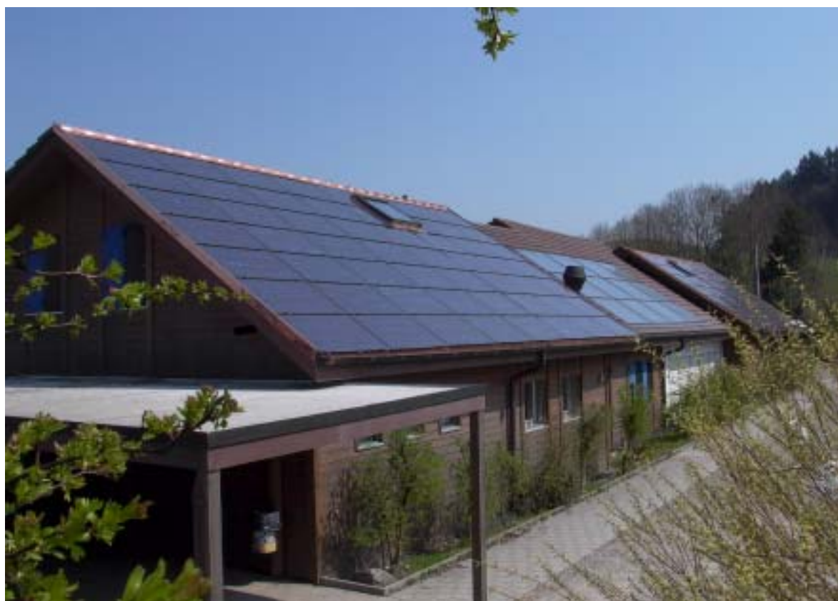
Abb. 5 MegaSlate Anlage mit 15.5 kWp (April 2003)
