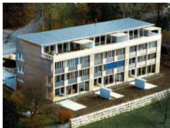
Figur 15: 16 kWp Dachintegration SunnyWoods (Bildquelle Architekturbüro Beat Kämpfen)
