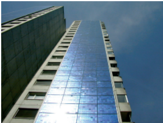
Figur 18: 80 kWp Fassade Bern Wittigkofen (Bildquelle NET)
