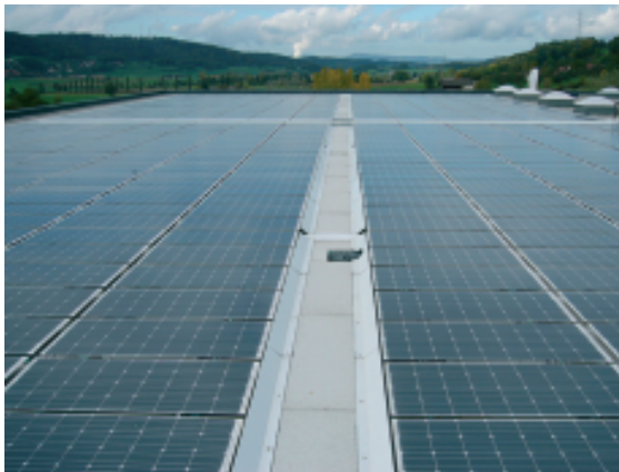
Figur 14: 62 kWp Anlage mit PowerGuard Modulen (Bildquelle Zagsolar)
