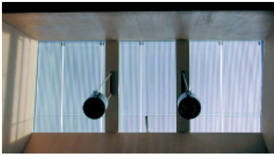
Figur 24: PV-Beschattungsanlage Würth Chur (Bildquelle NET)
