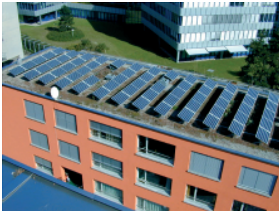
Figur 17: Gründachanlage Solgreen Kraftwerk 1 Zürich (Bildquelle NET)
