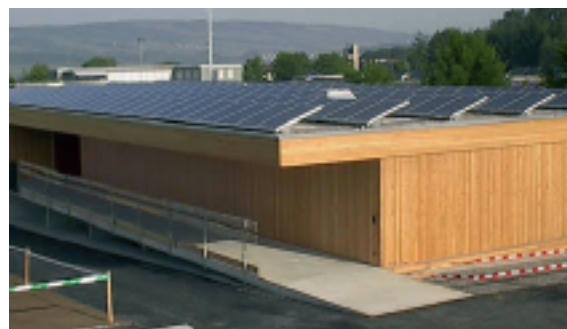
Figur 16: 27 kWp Alustand Hünenberg (Bildquelle Urs Bühler Energy Systems)
