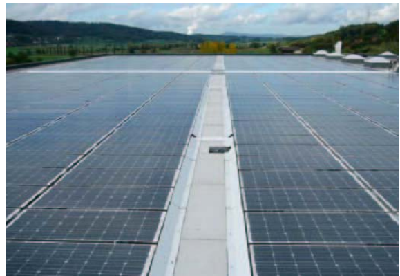
Figur 11: 62 kWp Anlage mit PowerGuard Modulen (Bildquelle: Zagsolar)
