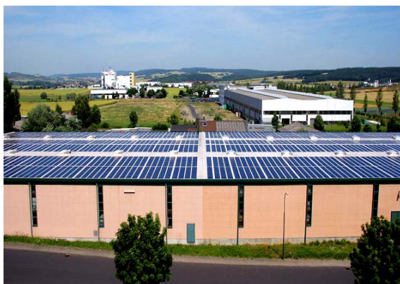
Figur 4: 188 kWp Solar Dach in Fulda (Bildquelle Sarnafil)
