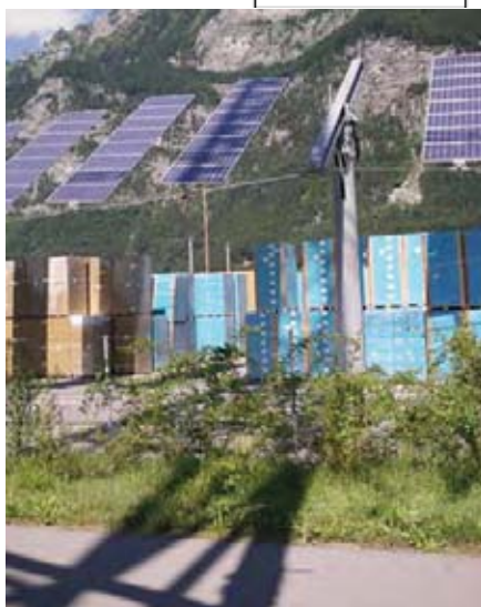
Abbildung 6 Schattenwurf des Hochspannungsmasten am 9. Aug 2010. Im linken Teilbild ist die Beschattung um 15:20 zu sehen, die links vom Zwischenträger den Modulträger Nr. 20 der Länge nach beschattet (Modulträger 20 und 19 bilden den Strang 1 des Wechselrichter 4, siehe Eintrag der geminderten Leistung von 0.9kW in Tabelle 2 zum Zeitpunkt 15:15). Im rechten Teilbild ist der Schatten um 17:30 ersichtlich, den ein Strassenbeleuchtungsmast auf Modulträger Nummer 8 im Vordergrund wirft, wodurch dessen erstes Modul an der rechten unteren Ecke im Umfang von ca. zwei Solarzellen beschattet wird. Die Leistung sinkt durch die Wirkung der Bypassdioden in diesem Modul nur minimal auf 2.5kW ab (siehe Tabelle 2 in der ersten Zeile beim Eintrag Modulträger 7 bis 8)
