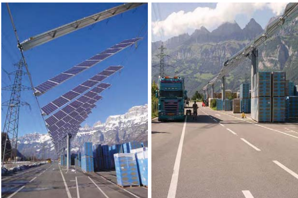
Abbildung 1 Blick auf die zweiachsige Solar Wings Nachführung der Flumroc AG, die über dem Aussenlager der Flumroc in Flums Anfang 2010 realisiert wurde. Die Zwischenstützen haben einen Abstand von 35m und je 10 Modulträger sind im Abstand von 3.2m auf den Trageseilen zwischen zwei solcher Zwischenstützen montiert.
