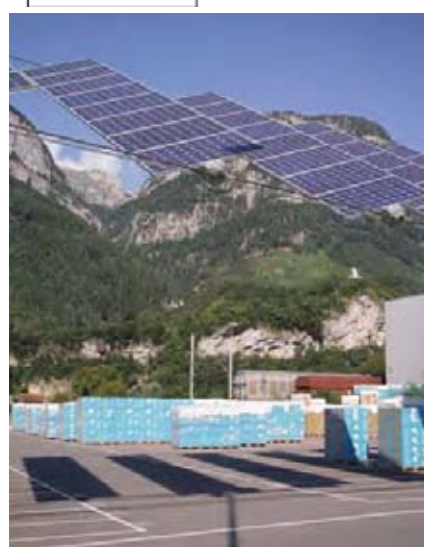
Abbildung 6 Schattenwurf des Hochspannungsmasten am 9. Aug 2010. Im linken Teilbild ist die Beschattung um 15:20 zu sehen, die links vom Zwischenträger den Modulträger Nr. 20 der Länge nach beschattet (Modulträger 20 und 19 bilden den Strang 1 des Wechselrichter 4, siehe Eintrag der geminderten Leistung von 0.9kW in Tabelle 2 zum Zeitpunkt 15:15). Im rechten Teilbild ist der Schatten um 17:30 ersichtlich, den ein Strassenbeleuchtungsmast auf Modulträger Nummer 8 im Vordergrund wirft, wodurch dessen erstes Modul an der rechten unteren Ecke im Umfang von ca. zwei Solarzellen beschattet wird. Die Leistung sinkt durch die Wirkung der Bypassdioden in diesem Modul nur minimal auf 2.5kW ab (siehe Tabelle 2 in der ersten Zeile beim Eintrag Modulträger 7 bis 8)
