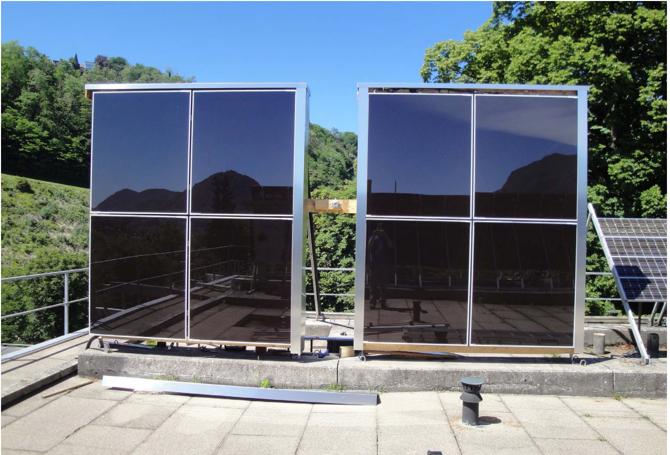
Figur 5: Feldtest von Prototypen aus dem Projekt PV Foamglas beim ISAAC SUPSI: Vorgehängte PV-Testfassade (links), geklebte PV-Testfassade (rechts) (Bildquelle: Basler & Hofmann).
