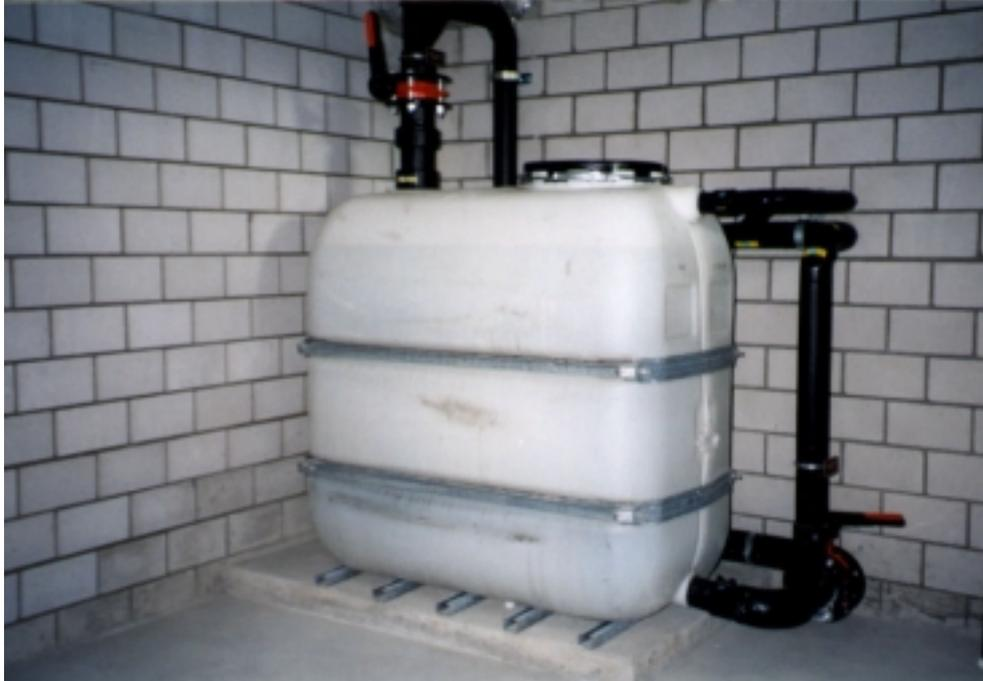
*Figur 6.1 Über die warme Oberfläche heizt dieser Tank den Trocknungsraum kostengünstig und energiesparend*
