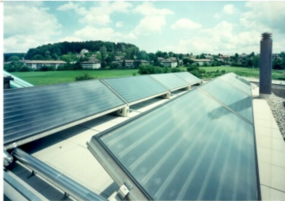
*Figur 8.1 Rund 21 m<sup>2</sup> Sonnenkollektoren erwärmen rund 50% des jährlichen Warmwasserbedarfes von 35 Menschen*
