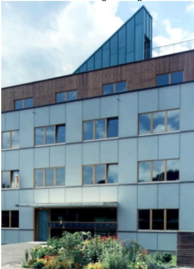
Figur 3.4 Die Holzfassadenkonstruktion (unten mit Zementfaserplatten verkleidet) ermöglicht eine schlanke Wand bei gleichzeitig sehr guter Wärmedämmung
