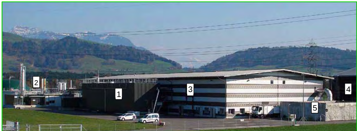
Abb. 2.2: Übersicht über die Anlage der SFPI: 1: Feststofffermenter, 2: Flüssigvergärung und Gas-aufbereitung, 3: Halle für Gärrestaufbereitung und Zwischenlagerung von festem Gärgut, 4: abgedeckter Lagertank für Konzentrat, 5: Biofilter (Bild: SFPI, 2013)
