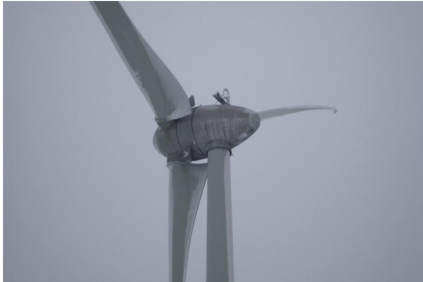
Abb. 42: WEA 1 mit abgeschalteter Blattheizung und vereisten Rotorblättern.
