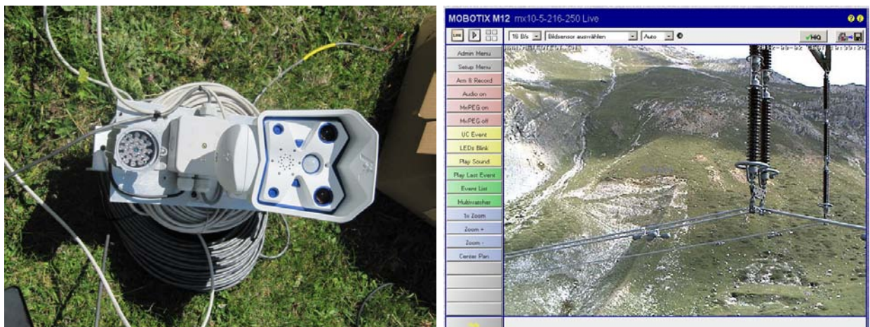
Abb. 3: Web-Kamera vor der Installation (links) und Aufnahme der Leitungen und Isolatoren (rechts) auf der Lagalb.
