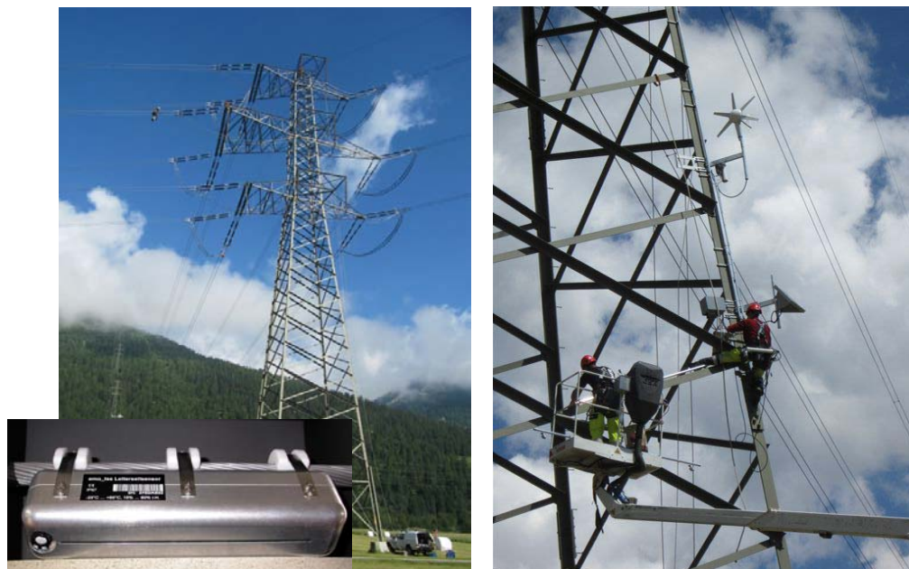
Abb. 2 Messstandort in La Punt. Auf Höhe des zweiten Auslegers wird gerade der Leiterseil-Temperatur-Sensor (kleines Bild) am äusseren Leitungsstrang in Richtung Robbia montiert (links). Das Bild rechts zeigt die Montage der Basisstationen sowie die Geräte zur Energielieferung.
