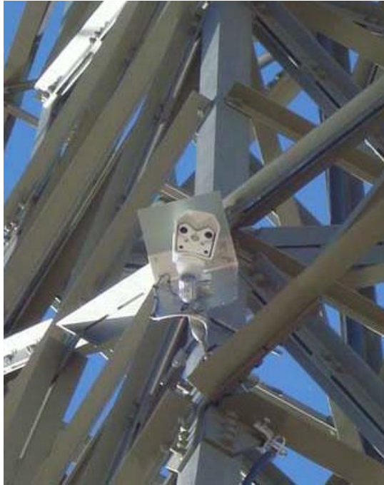
Abb. 4 Webcam des Typs Mobotix M12 mit Schutzdach am Mast installiert.
