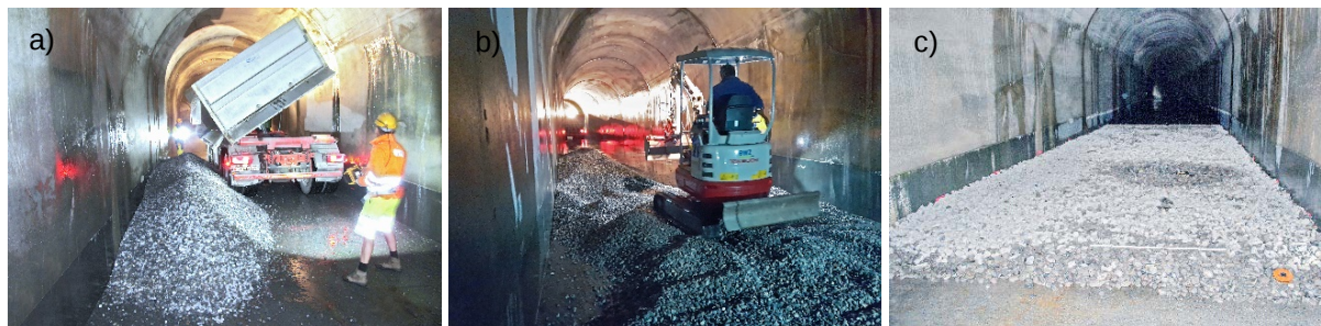
Abbildung 3: (a) Seitenkipper beim Entladen, (b) Bagger beim Einbau des Sedimentkörpers, (c) Sedimentkörper vor dem Versuch mit oberwasserseitiger keilförmiger Anordnung (Blick in Fliessrichtung)
