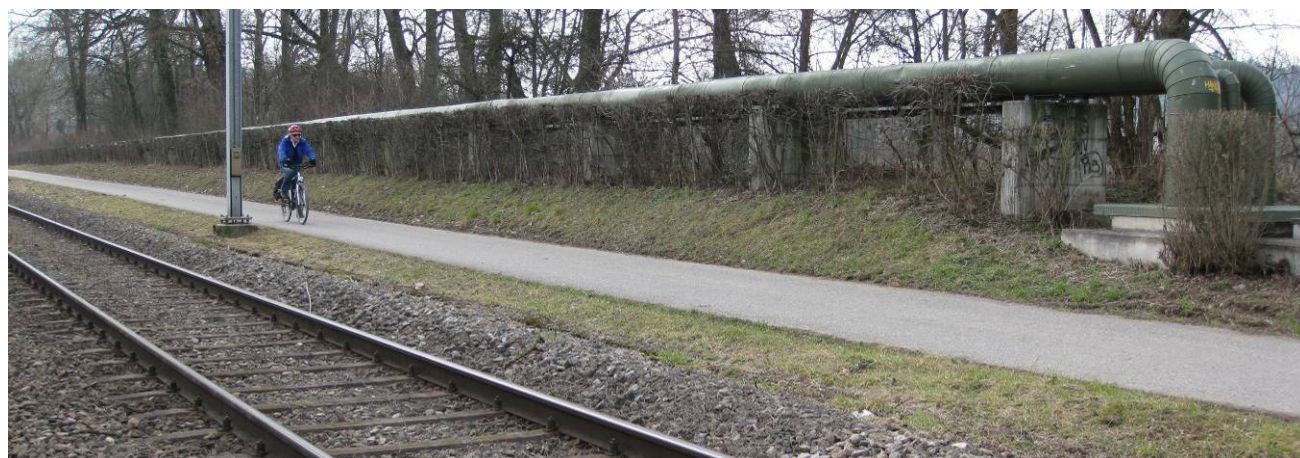
Bild 38: Die 22 bar Dampfleitungen für die Prozesswärme verlaufen teilweise unmittelbar neben dem Industriegleis. Eine Füllstation könnte mit wenig Aufwand realisiert werden. Siehe auch Anhang V. Foto: Roger Waller
