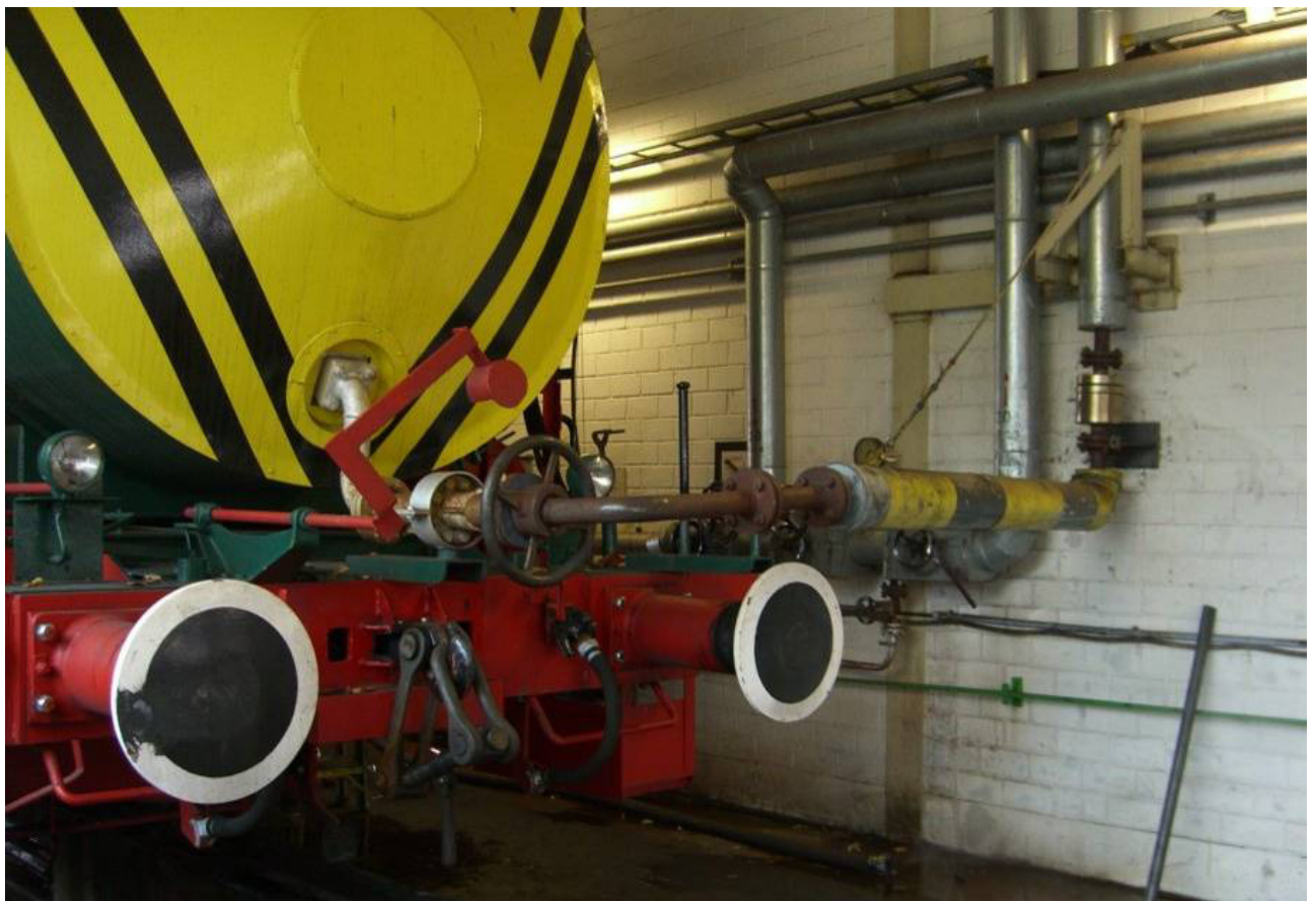
Bild 14: Ladevorrichtung für Dampfnachfüllung beim Grosskraftwerk Mannheim. Das Laden erfolgt unbeaufsichtigt. Der Dampfstrom stoppt automatisch, sobald im Druckbehälter der gleiche Druck erreicht worden ist wie in der Zuleitung. Foto: Roger Waller
