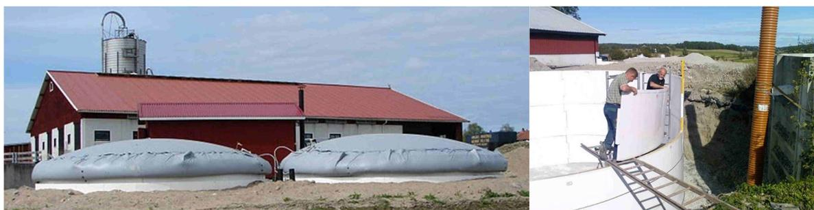
**Figure 4-8 :** En haut : Digesteur BioWaz® à Olpers Farm, Suède. En bas : Construction d'une installation BioWaz® à Tomb, Norvège. [Source : www.biowaz.com]
