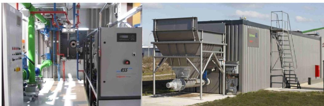
**Figure 4-6** : (à gauche) Station de dosage PASCO alimentant le digesteur EUCOLINO. (à droite) Conteneur « AIO ». [Source : Schmack Biogas.]
