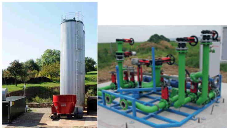
Figure 4-10 : (à gauche) Digesteur vertical BEBRA Biogas. (à droite) Système de pompage sous le digesteur
