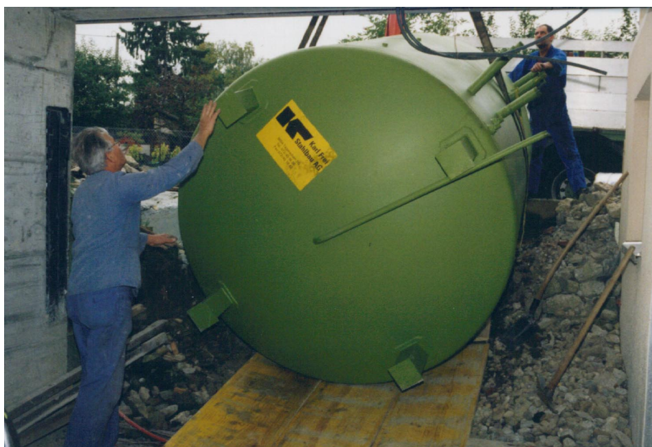
Figure 2 : introduction de la cuve dans la cave
