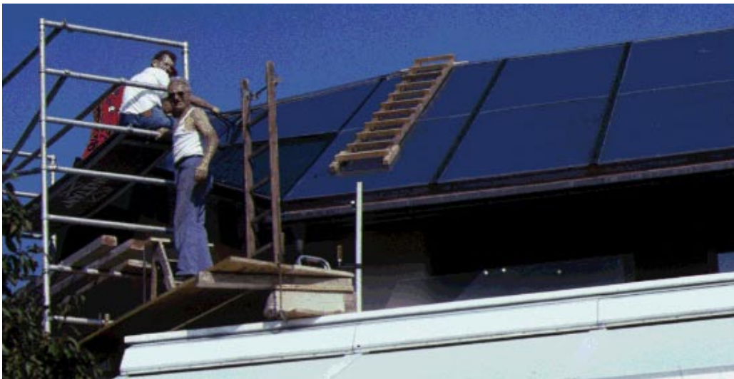
Figure 3 : Intégration des capteurs en toiture.
