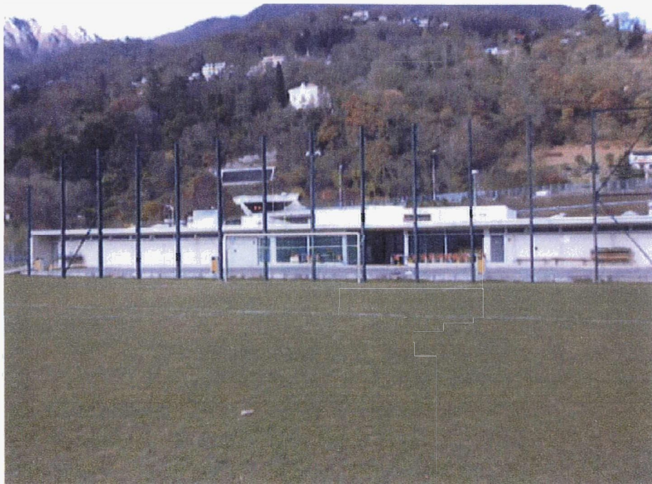
Vista Sud edificio con portale galleria
