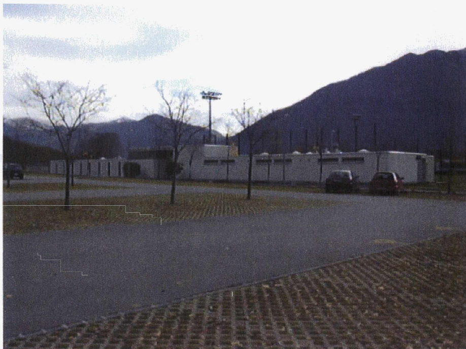
Vista Nord edificio di servizio
