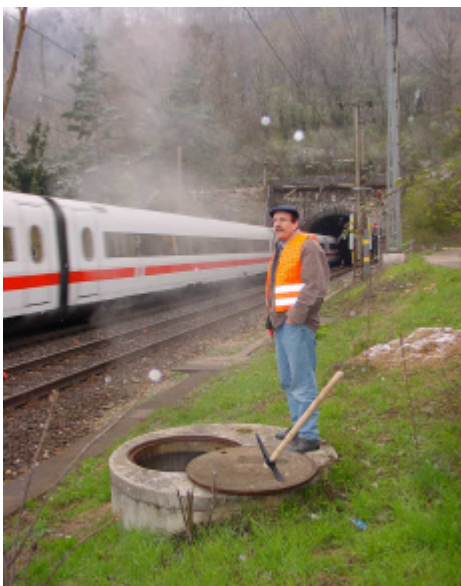
Wasserfassungsschacht am Hauensteintunnel
