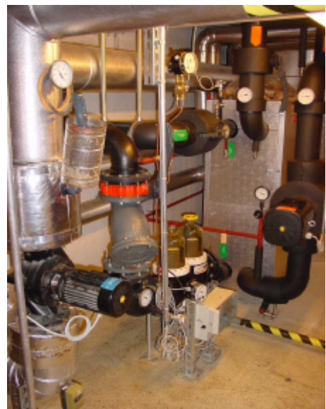
Filtereinheit in der Wärmezentrale
