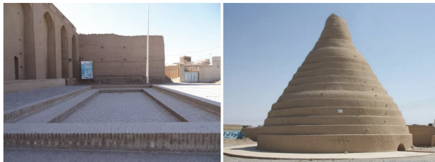
Abb. 1: Becken zur nächtlichen Eisproduktion (links) und Eisspeicher (rechts) im Iran [5][6]
