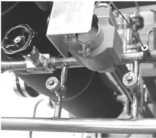
Abb. 2-1: Zwischendruck - Expansionsventile
