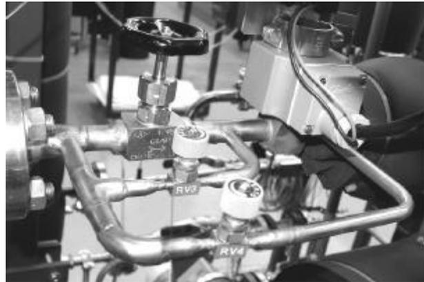
**ABBILDUNG 3: NIEDERDRUCK – EXPANSIONSVENTILE**
