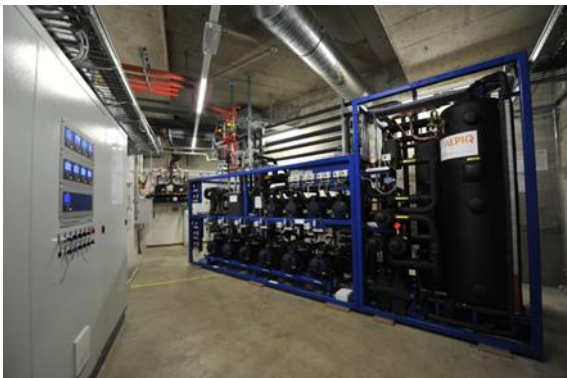
Bild 6: Betriebsbereite transkritische CO 2 -Booster-Kälteanlage.
