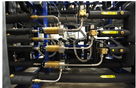
Bild 7: Die drei in die Kälteanlage eingebundenen Ejektoren.
