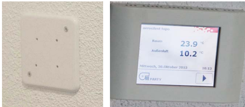
Bild 4: Abdeckung des Temperaturfühlers „OG-Wohnen“ (links) und Anzeige der gemessenen Temperatur am Temperaturfühler und der Aussenlufttemperatur an der Klimastation (rechts) (Quelle: IEBau).
