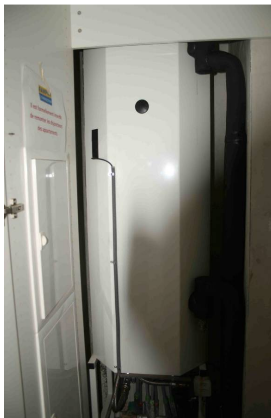
Figure 16 : Boiler individuel de stockage d'eau chaude sanitaire dans un appartement (300 L)
