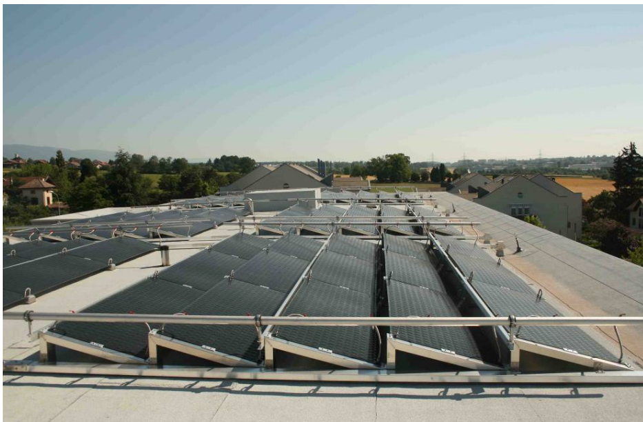
Figure 14 : Capteurs solaires Energie Solaire SA installés sur le toit d'un immeuble de Solarcity
