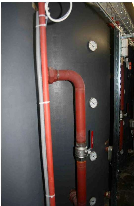
Figure 15 : Ballon de stockage en chaufferie (1'500 L)
