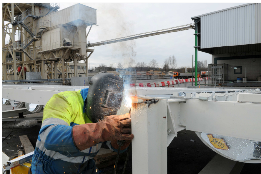
Figure 4 : Montage de la structure métallique, avec passage aérien en arrière-plan
