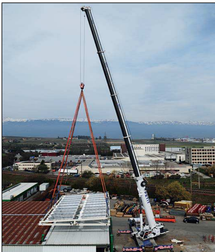
Figure 5 : Installation du champ solaire sur le toit de l'atelier de Colas Genève
