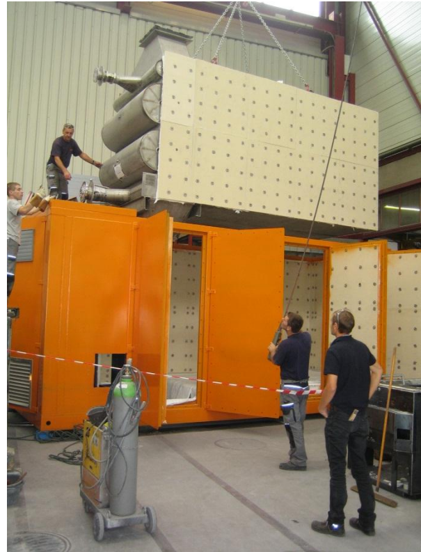
Abbildung 8: Montage Heissluft-Wärmetauscher
