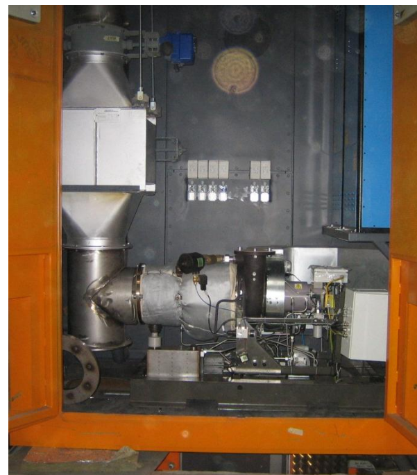
Abbildung 9: Turbinenraum bei Montage
