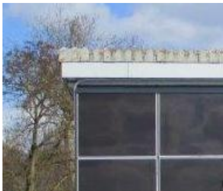
Bild 36: Verschattung durch den Traufenaufbau (Quelle: Basler & Hofmann AG).
