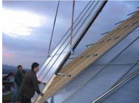
Bild 20: Montage von grösseren Solarkollektorelementen, Fotos: Gerold Weber Solartechnik GmbH, (Quelle: solarserver).
