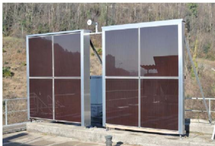
Bild 25: Feldtestanlage Links hinterlüftete Fassade, rechts verklebte Fassade (Quelle: SUPSI).
