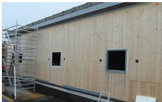
Bild 29: Ansicht der Fassade vor dem Anbau der Anlage (Basler & Hofmann AG).
