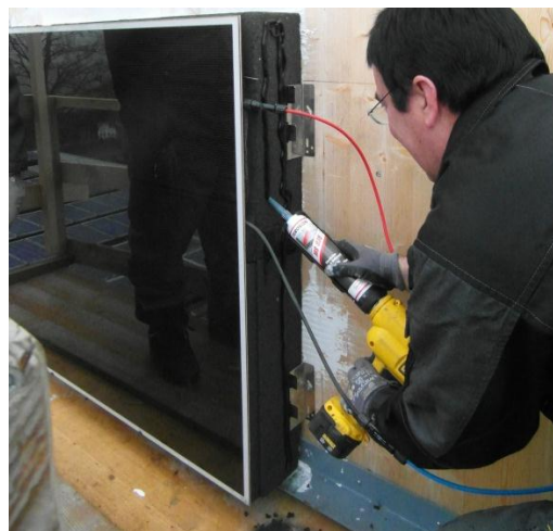
Bild 32: links: Auftragen des Klebers auf der Rückseite des PV-Foamglasmoduls; rechts: Auftragen der seitlichen Abdichtung mit Kartusche. Zwei Z-Anker sichern das Modul, bis der Kleber bindet. Das unterste Modul wird auf einen Stahlwinkel gesetzt. Die Kabel werden in den Stößen versenkt. Die Kerben zur Versenkung der Kabel können einfach auf der Baustelle mit einem Schraubenzieher gezogen werden. (Quelle: Basler & Hofmann AG).
