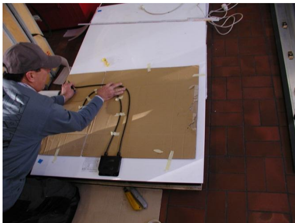
Bild 6 Kabelführung links: Vorbereitung einer Schablone für die Aussparungen, rechts: eigefräste Aussparungen (Quelle: Basler & Hofmann AG).
