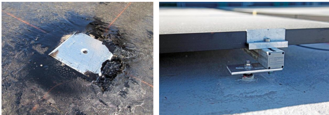
Bild 16 Flachdachverankerung, links: Krallenplatte in Foamglas vor dem Setzen der Stockschraube und Abdichten, rechts: Flachdachverankerung fertig abgedichtet (Quelle: Pittsburgh Corning (Schweiz) AG).
