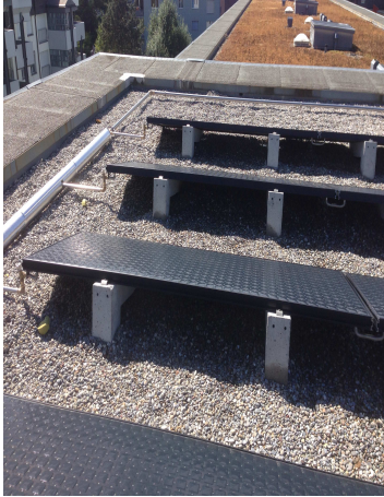
Abbildung 3 – die Kollektoren sind aufgeständert auf dem Flachdach
