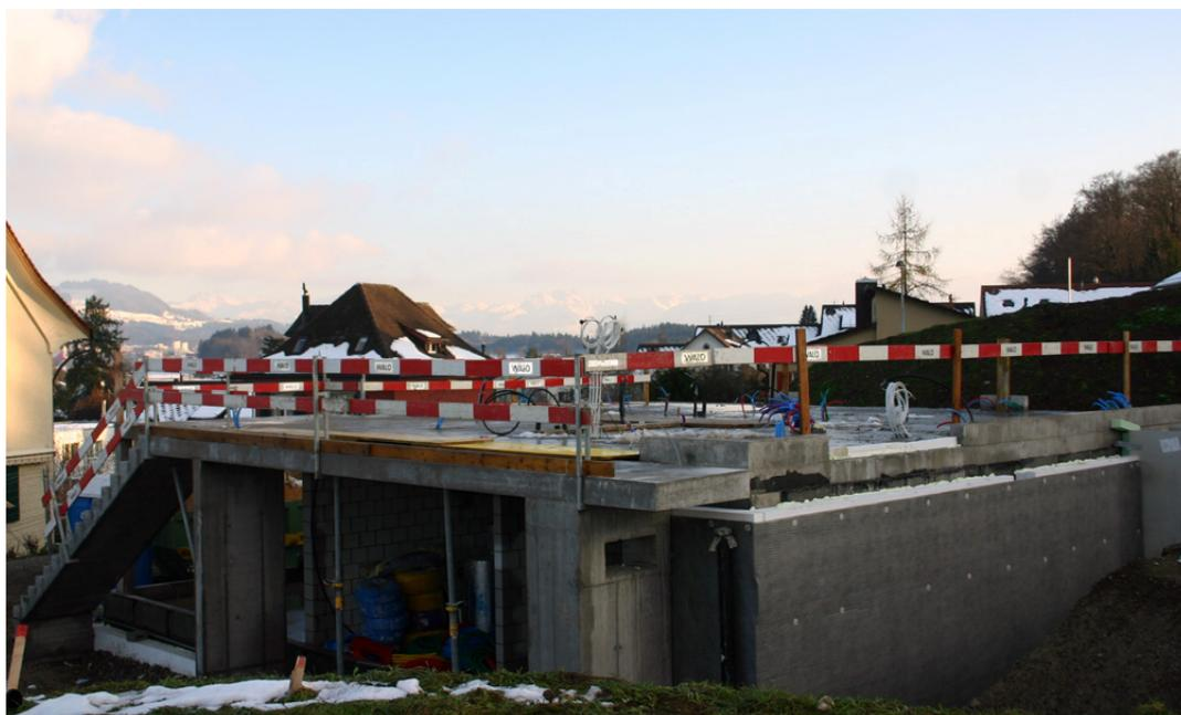
Abb. 1: Abschluss der Baumeisterarbeiten: Grosse Teile der Bodenplatte sowie der Boden des EG sind thermisch aktivierbar. Das gesamte UG ist durch 25 cm Dämmung zum Erdreich hin gedämmt. Rechts im Bild wird noch eine Hinterfüllung eingebracht werden. Der Holzelementbau wird im März 2013 aufgerichtet.
