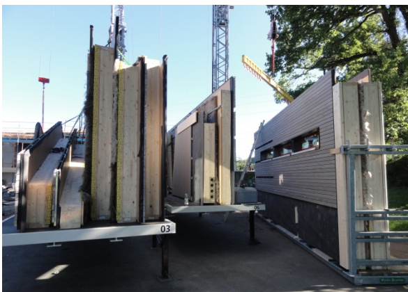
Figur 11: Die Fassadenelemente stehen auf der Baustelle zur Montage bereit.
