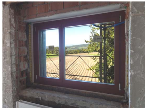
Figur 15: Die vergrößerten Fenster wurden kurz vor der Fassadenmontage herausgebrochen (links) und sind nach der Montage bereits wieder verschlossen (rechts)
