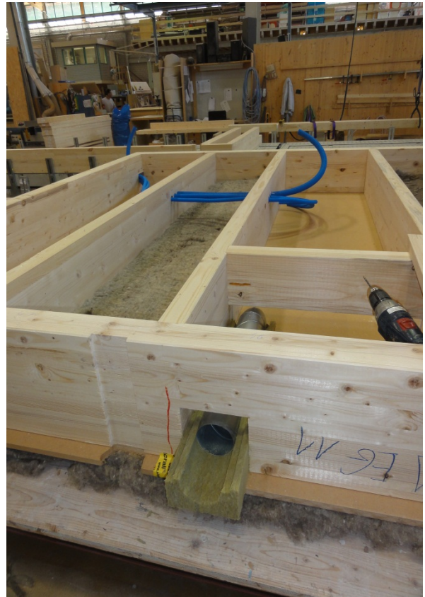
Figur 6: Einfaches Rahmensystem in der Vorfabrikation (liegend). Die Lüftungsrohre werden durch spezielle Mineralwollschalen im Brandfall geschützt.
