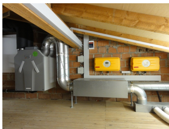
Figur 21: Zwei der drei Lüftungsgeräte für Wohnung und Schulräume, mit Lüftungsverteilung und Schalldämpfern im Dachraum. Ebenso sichtbar die beiden Wechselrichter der Solaranlage.
