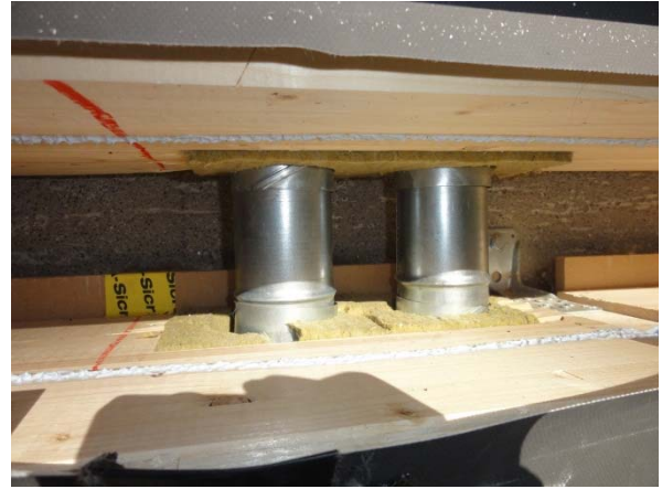
Figur 14: Vor dem Absenken der oberen Elemente werden die eingelegten Lüftungsleitungen mit Teleskoprohren verbunden
