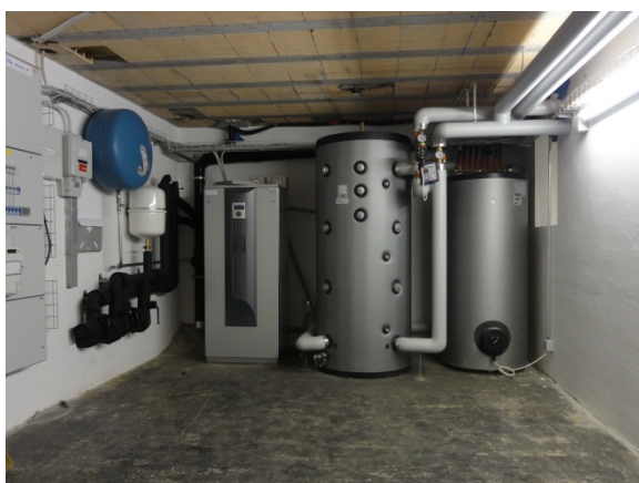
Figur 20: Die neue Technikzentrale mit den Elektrozählern links, der Wärmepumpe rechts und den beiden Wärmespeichern (rechts)
