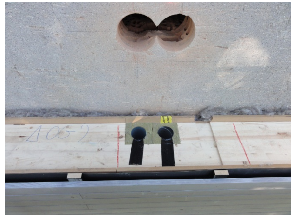
Figur 10: Wandbohrungen zur Durchführung der Lüftungsrohre
