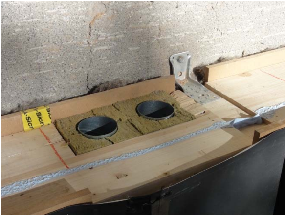
Figur 13: Die Elemente werden mit Metallwinkeln an der Fassade verankert.
