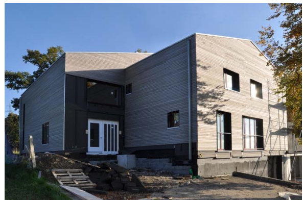
Figur 16: Das Schulhaus Krumbach vor und kurz nach der Montage der Fassadenelemente. Das Gerüst wurde bereits entfernt.
