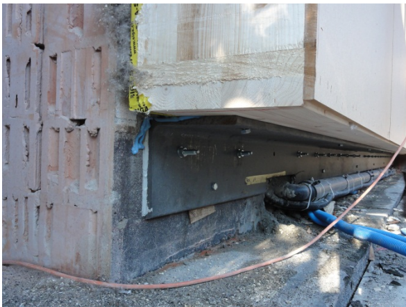
Figur 9: Stahlkonsole zur Aufnahme der Fassadenelemente
