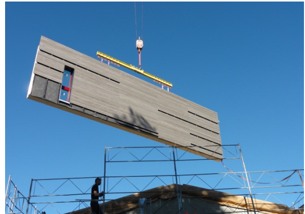
Figur 12: Ein Fassadenelement wird mit dem Kran in Position gebracht. Die fehlende Fassadenbekleidung dient zur Verschraubung der Elemente.
