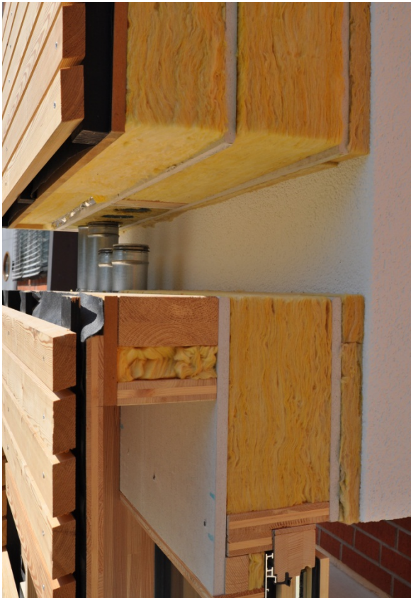
Figur 5: Vorgefertigtes Fassadenelement mit zwei Kammern. Hinten sind die Teleskopverbindungen der Lüftungsleitungen erkennbar.
