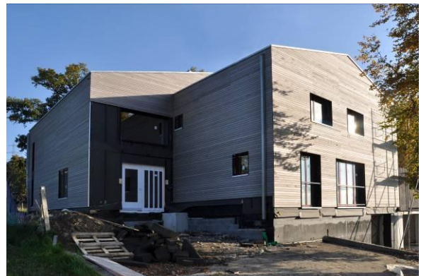
Figur 6: Schulhaus Krummbach vor und während der Erneuerung. Die vorgefertigten Module sind bereits montiert
