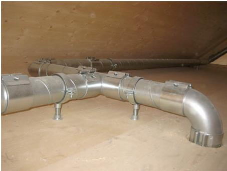
Fig.9: Zuluftkanäle in das Dacheschoss.
