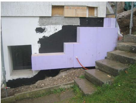
Fig.2: Die Erdberührten Aussenwände werden bis ein Meter unter Kellerdecke mit 30cm XPS gedämmt, um die Wärmebrücken gegen den unbeheizten Keller zu reduzieren.
