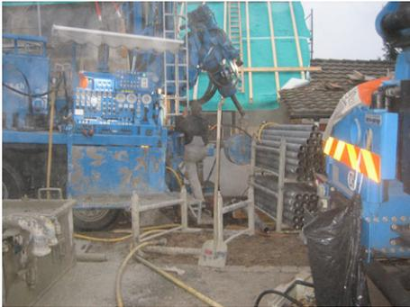
Fig.5: Die Erdsonde wird 140 Meter tief gebohrt.
