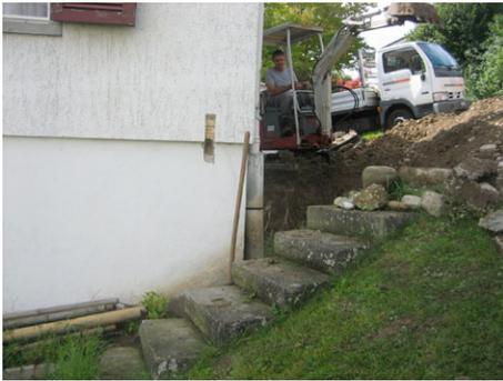
Fig.1: Aushubarbeiten für die Perimeterdämmung
