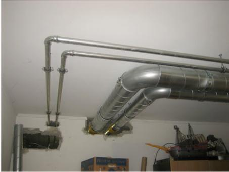
Fig.8: Heizverteilungen und Lüftungskanäle an der noch ungedämmten Kellerdecke;
