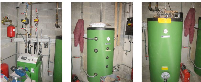
Fig.7: Wärmepumpe, Pufferspeicher, Warmwasserspeicher
