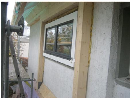
Fig.3: Neues Fenster mit 3-fach- Wärmeschutzverglasung von aussen an die noch ungedämmte Wand angeschlagen. Somit liegt das Fenster in der künftigen Dämmebene, der Festrahmen wird nahezu vollständig überdämmt werden; Die unvermeidliche Einbauwärmebrücke wird auf ein Minimum reduziert.
