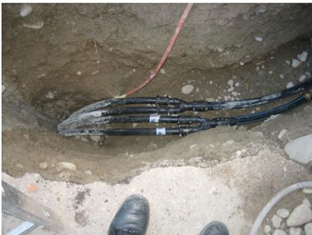
Fig.6: Die Einführung der Erdsondenleitung in 120cm Tiefe in das Haus
