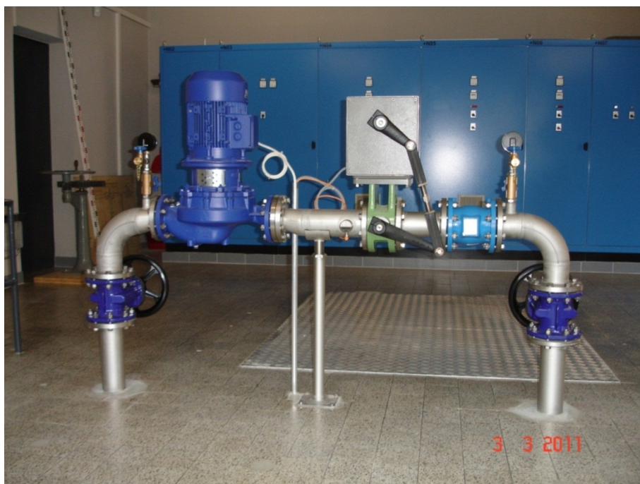
Abbildung 28: Notfallpumpwerk Hard mit 460 kW Leistung
