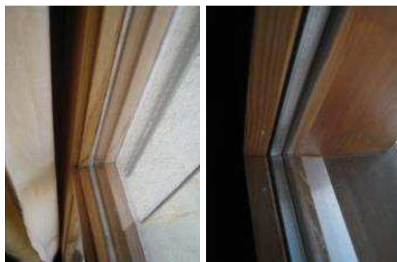
Figure 4: Intercalaire du vitrage : mastic à gauche et aluminium à droite
