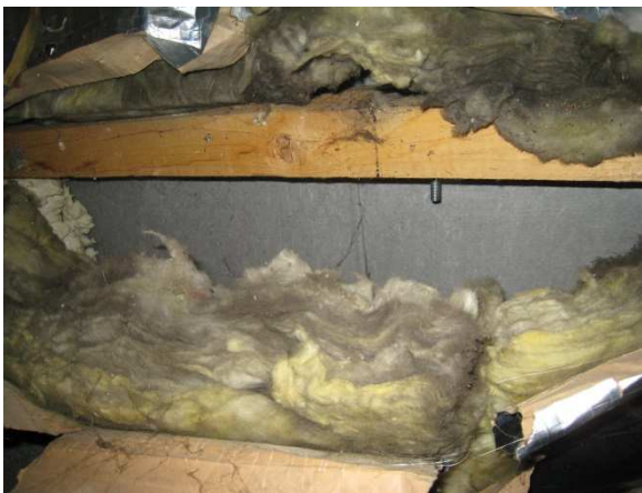
Figure 3 : Isolation entre chevrons
