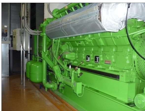
Figure 22 : Cogénération moteur à gaz, station d'épuration de Bern, 600kWélec
