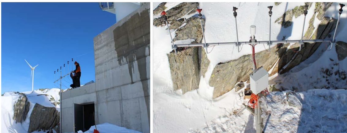
Abb. 6: Installation der Anemometer auf dem Gütsch.
